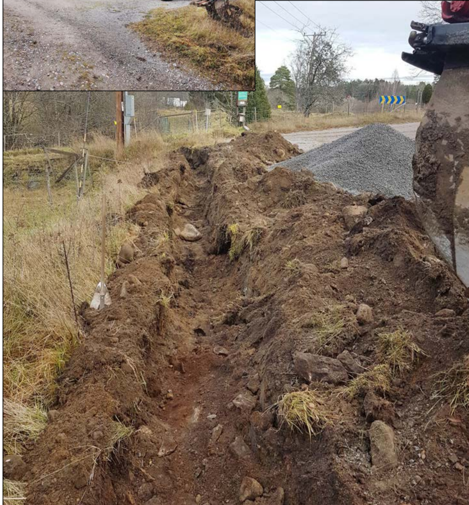
Figur 9. I schakt 5 påträffades bärlager överst med malmsten i botten. Foto från söder.
