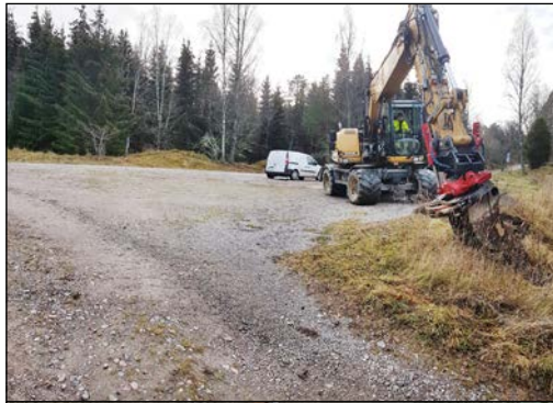
Figur 8. Schakt 5 inom gruvområde L2012:8596 som utgjordes av ett igenfyllt gruvhål med en grusad parkering anlagd ovanpå. Foto från nordväst.
