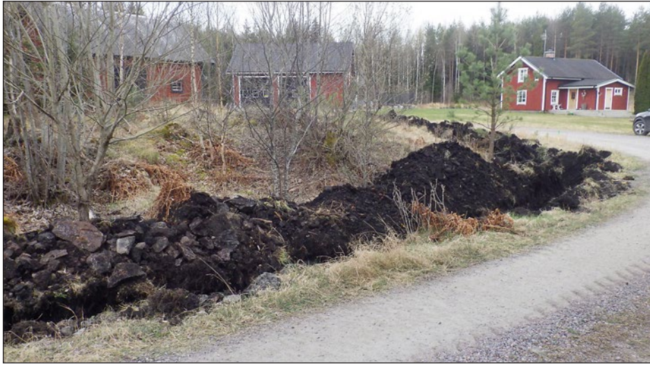
Figur 12. Utförd schaktning genom slagglager A5 vid bostadshus. Foto från öster.
