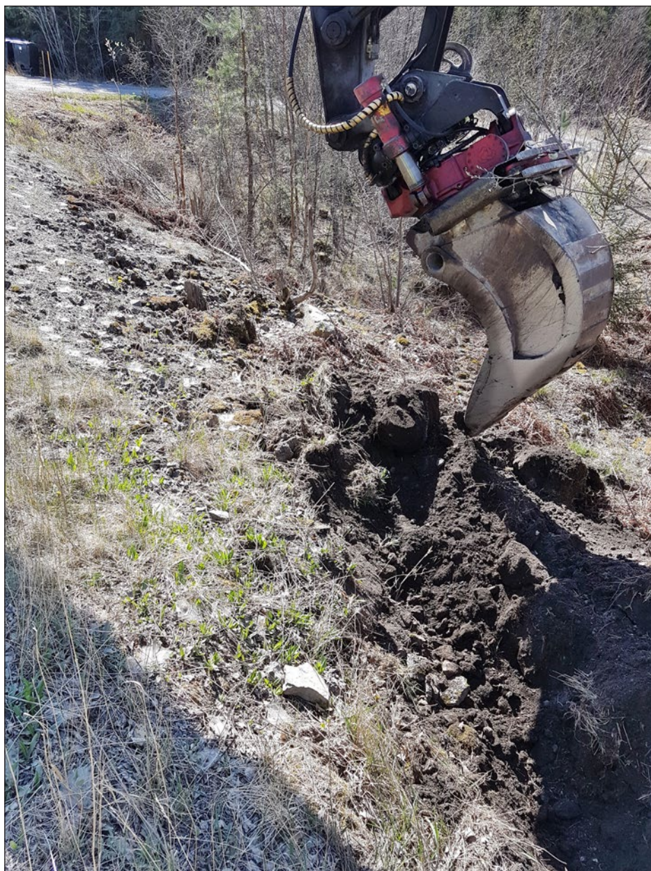
Figur 11. Schaktning av slagglager (A5) som nyttjats för vägfyllning. Foto från norr.
