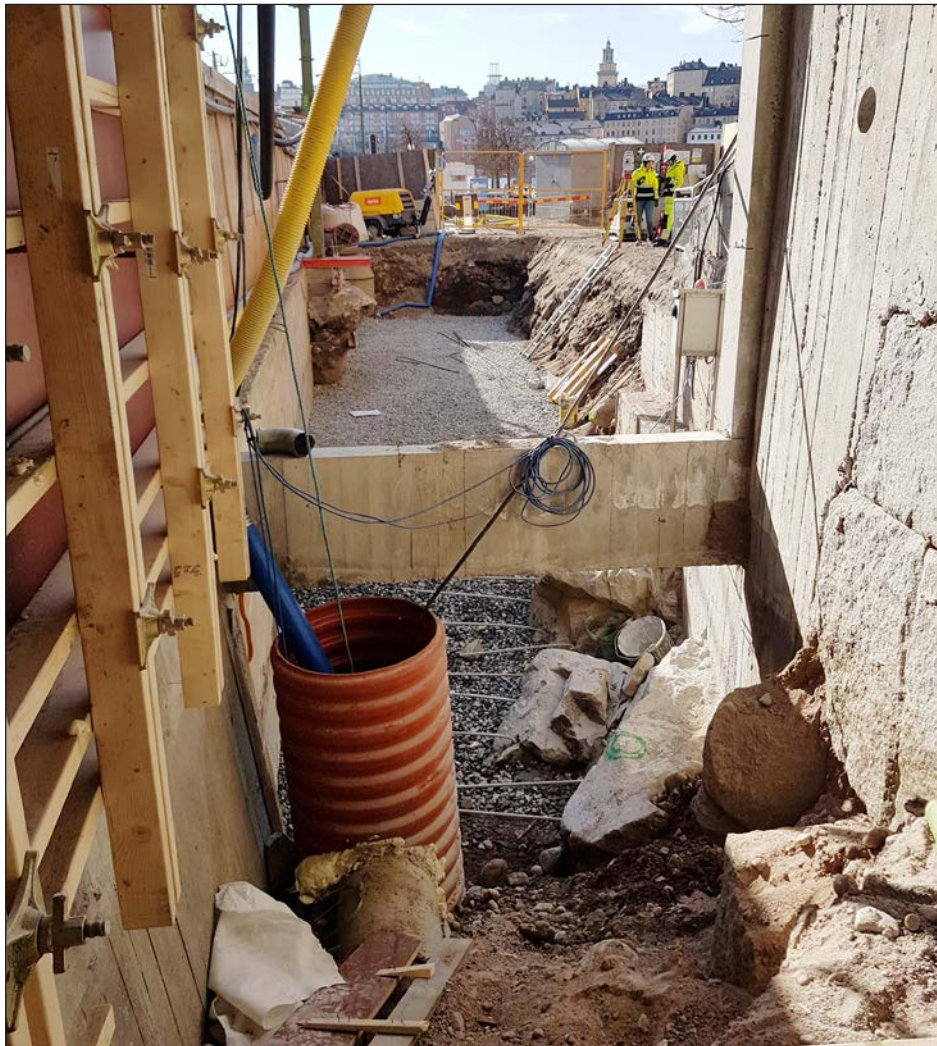
Figur 8. Utsikt från arbetstunneln mot Södermalm. Djupschaktet delvis igenlagt.
