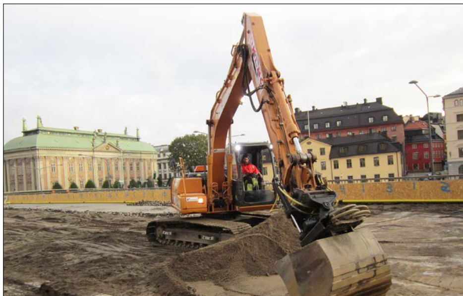
Figur 9. Schaktning vid spårtunneln. Betongskiktet synligt under sanden.
