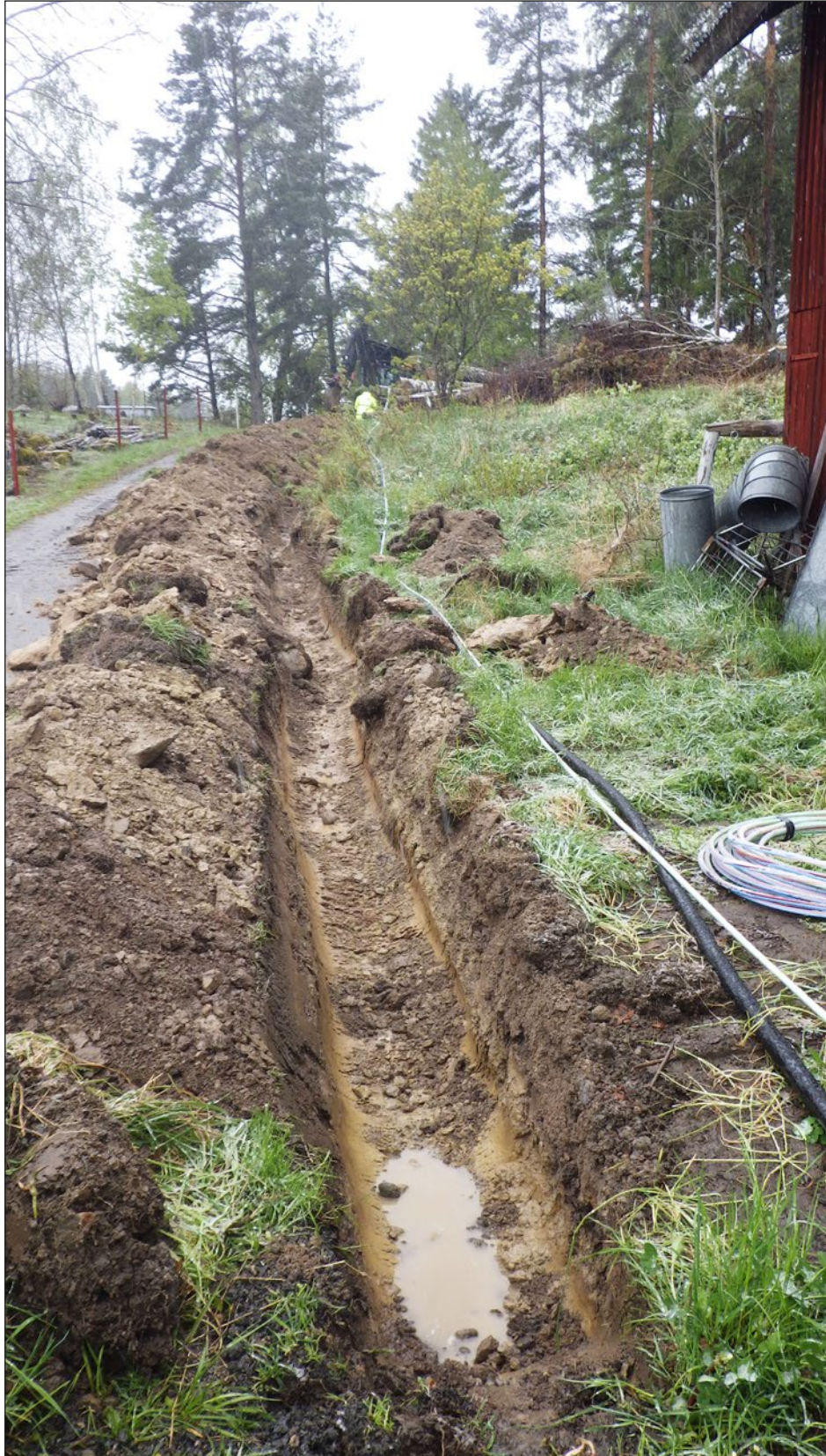
Figur 8. Det längre schaktet (N–S) sett från öster.
