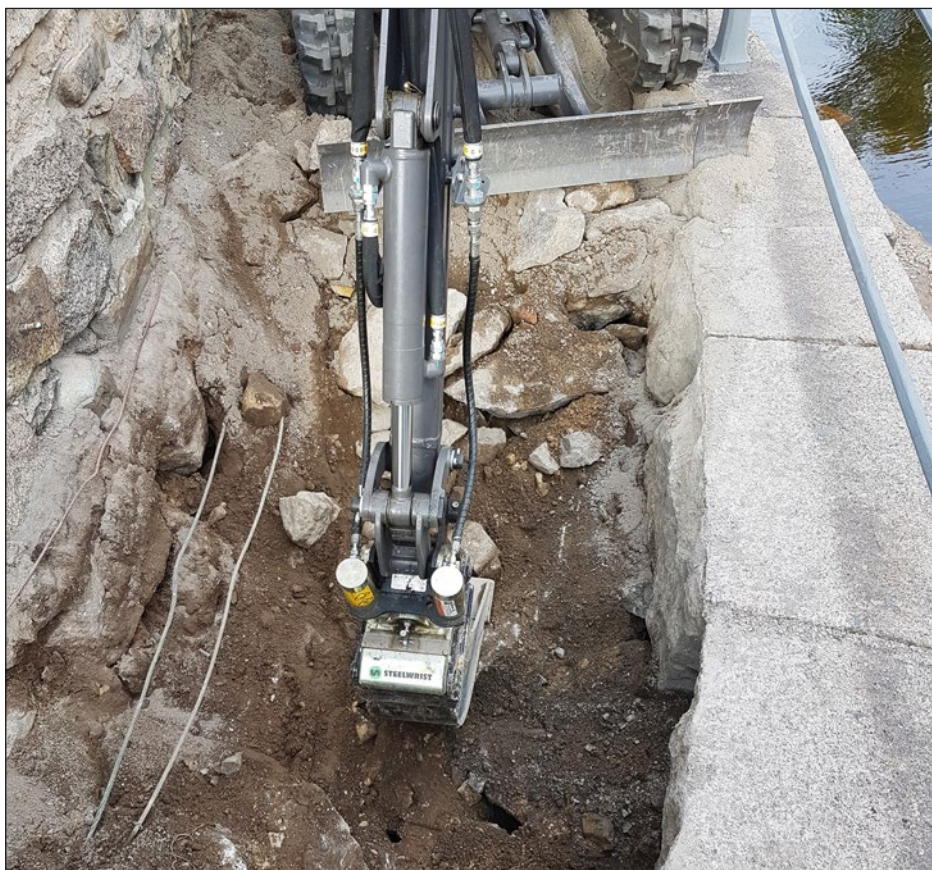
Figur 4. Vid schaktarbetet övervakade en arkeolog då grävmaskin grävde ned till nödvändigt djup. Här i bild syns toppen på de stora stenar som användes som bakfyll bakom strandmuren. Foto från söder.
