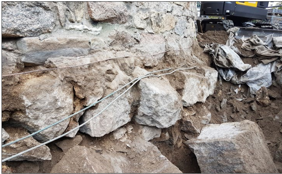
Figur 8. Rester efter tornets sockel som visade spår av förfall då stenar föreföll saknas emellan håligheter.
