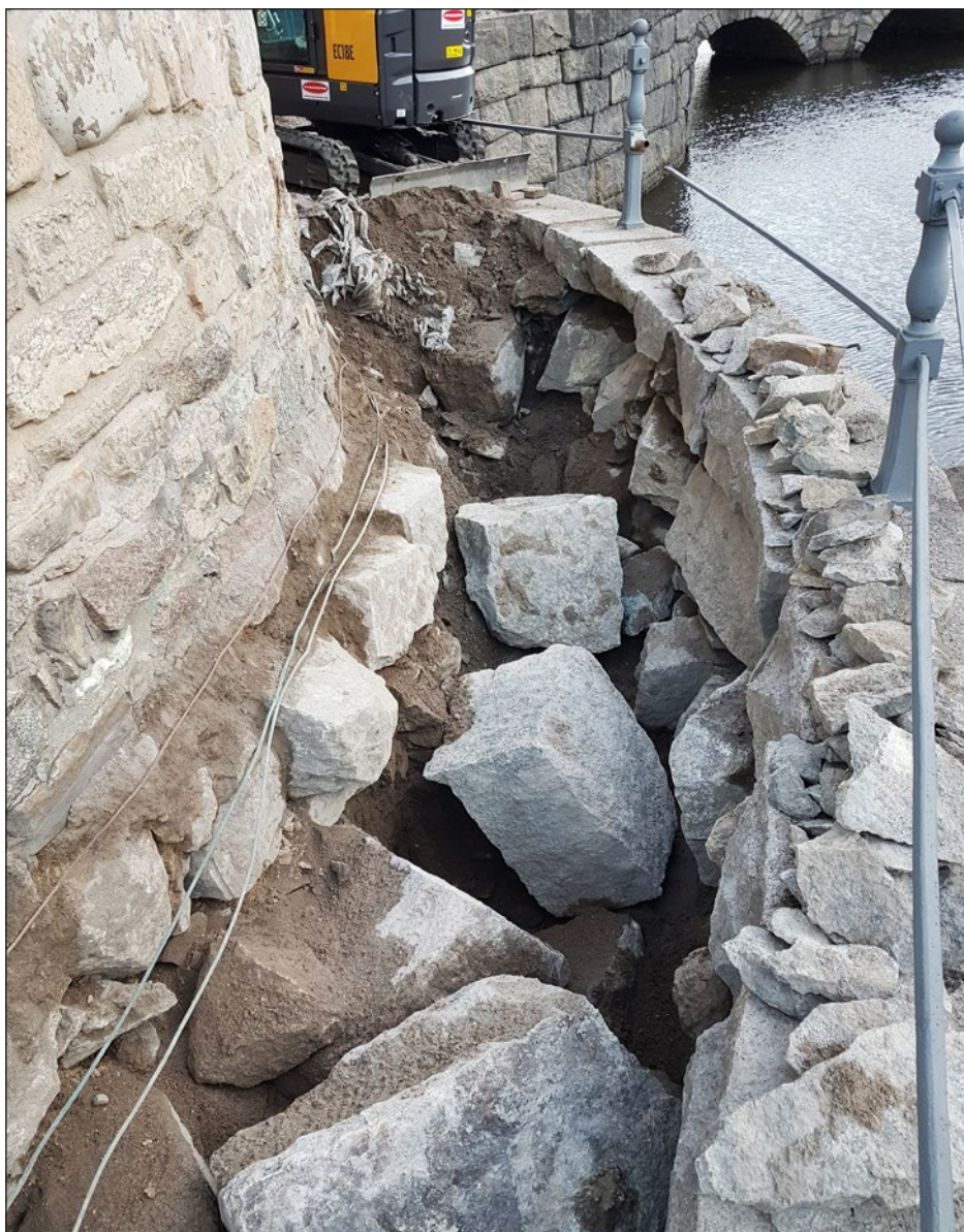
Figur 7. Bakom strandmuren låg en stenfyllning av huggna stenar som tolkades vara "misslyckade" stenar, vilka kom att nyttjas som fyllning istället för att ingå i strandmuren. Ovanpå strandmuren syns även de rikliga mängder skärviga stenar, vilka tillkommit då strandmurens stenar tillhuggits på plats. Foto från söder.
