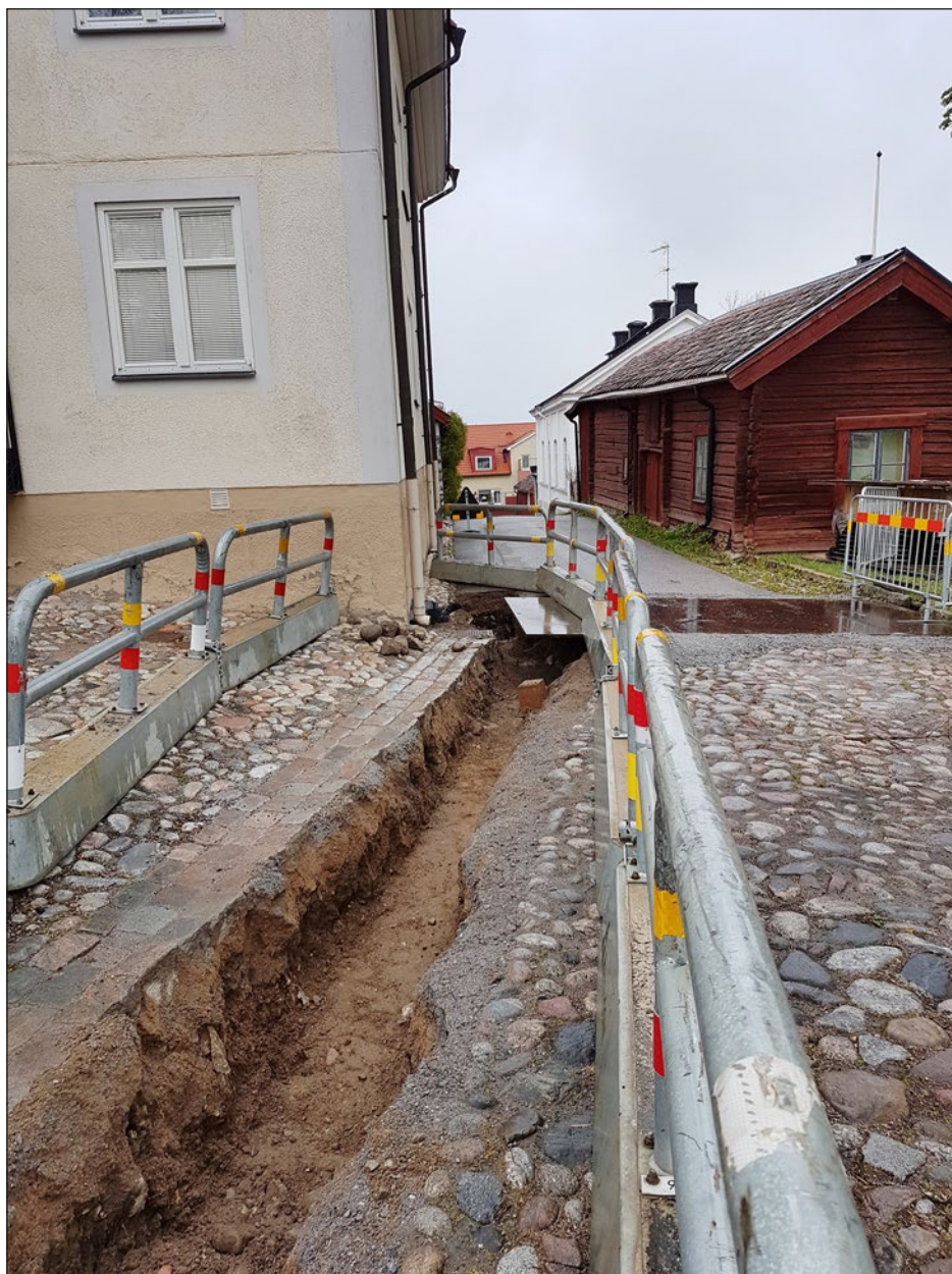
Figur 6. Schaktet genom Lilla gatan sett från söder.
