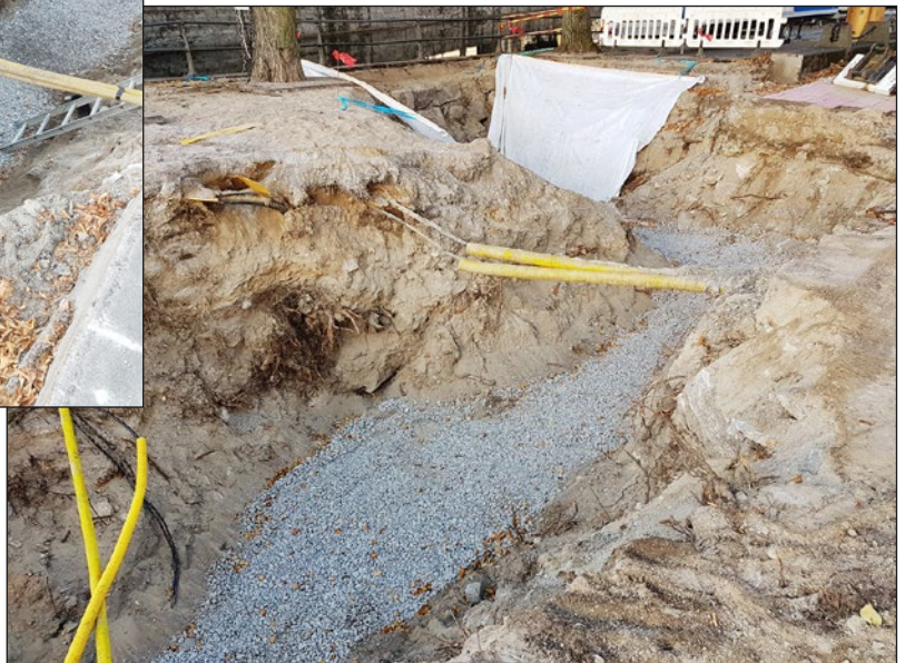
Figur 8. I bilden syns den södra änden av schakt 1. Schaktet utgjordes till stora delar av sandiga utfyllnadslager. Foto från norr.
