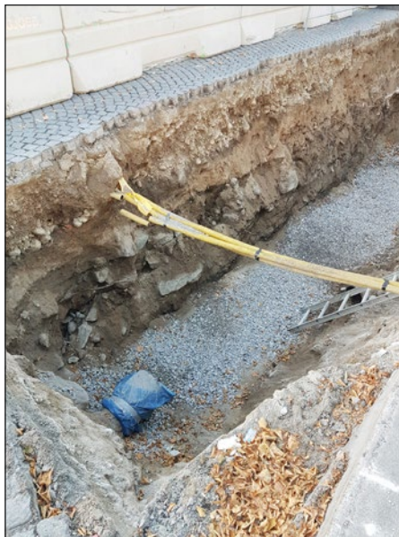
Figur 7. I bilden syns den norra änden av schakt 1. I den östra schaktväggen syns de stenmassor som utgjorde ett utfyllnadslager (A1) med stenar från den äldre bron som stod klar år 1791. Foto från norr.
