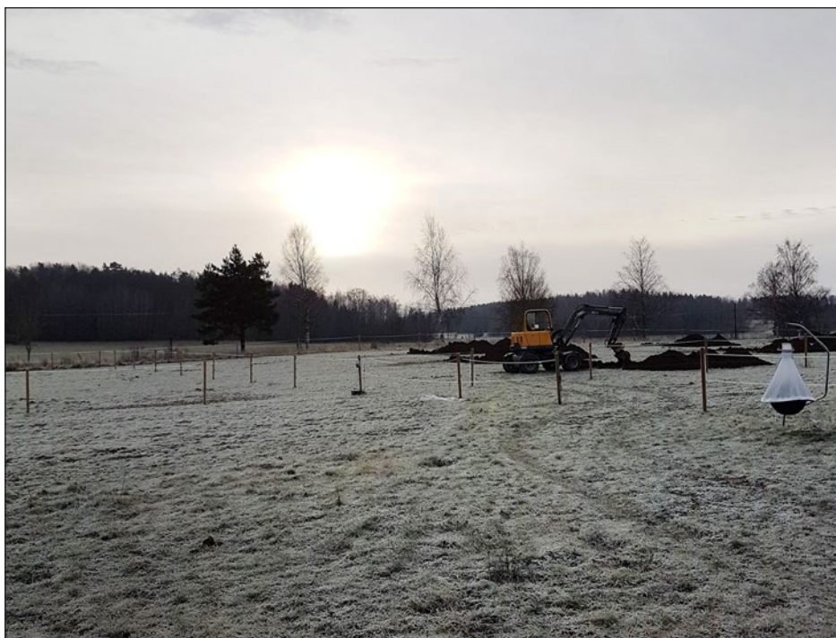
Figur 17. Schaktning pågår vid objekt 4. Foto från nordöst.
