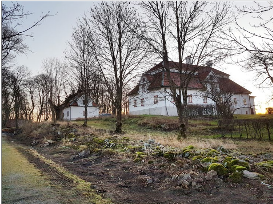
Figur 5. Det igenlagda schaktet med säteriets mangårdsbyggnad i bakgrunden. Foto från nordväst.
