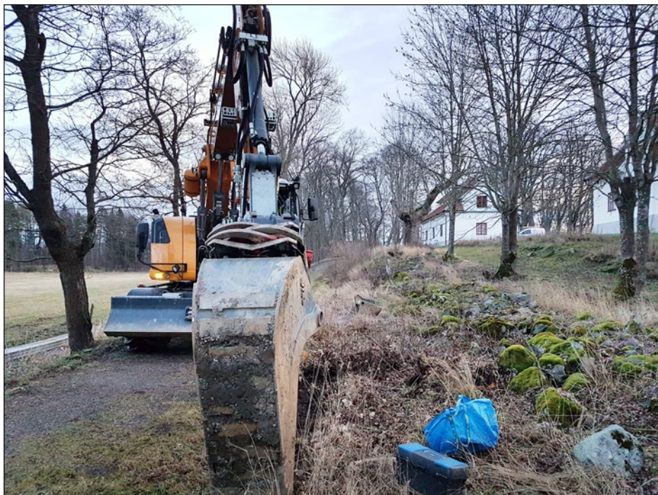
Figur 3. Schaktning pågår! Foto från väster.
