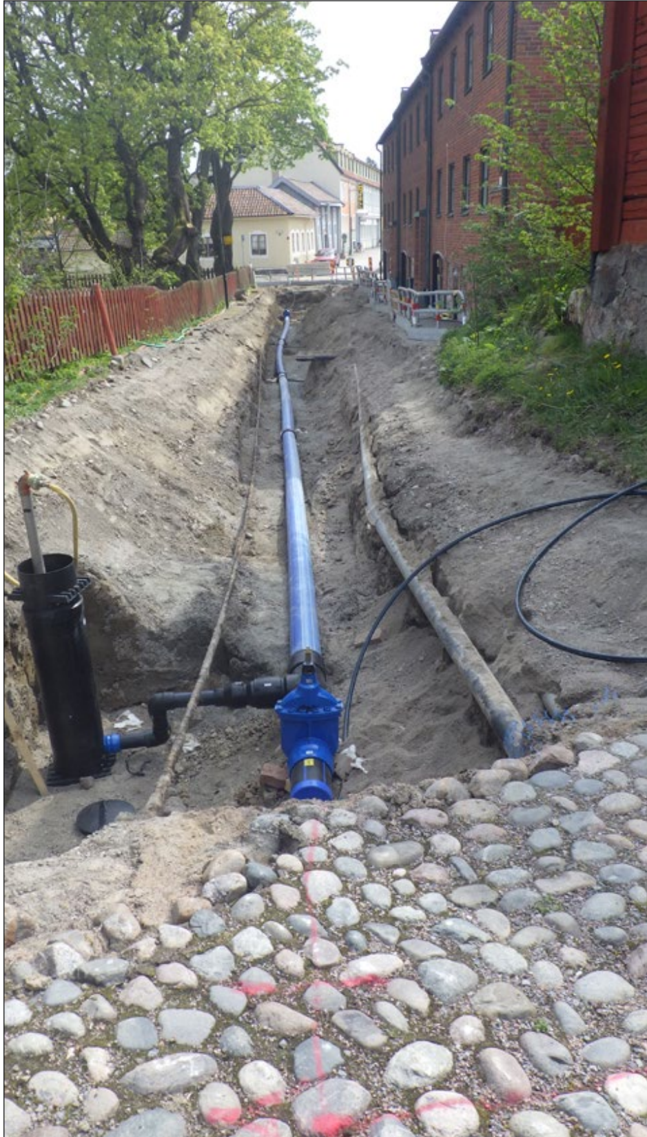
Figur 7. Schaktet längs Östra Långgatan. Från norr.
