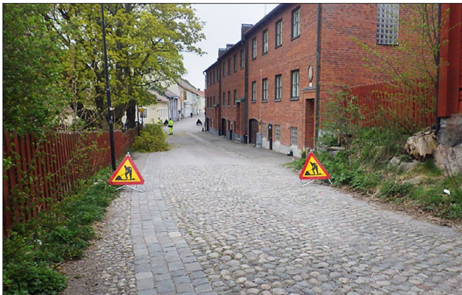
Figur 2. Del av Östra Långgatan innan schaktningen är påbörjad. Foto från norr.
