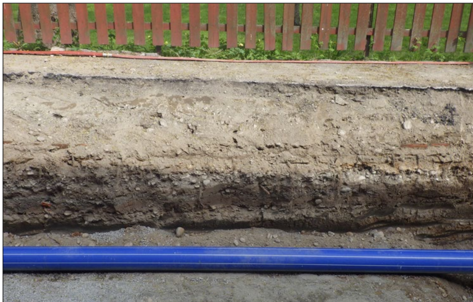
Figur 6. Exempel på den östra schaktväggens stratigrafi med bland annat en synlig ledningsdragning med tegelmarkering.
