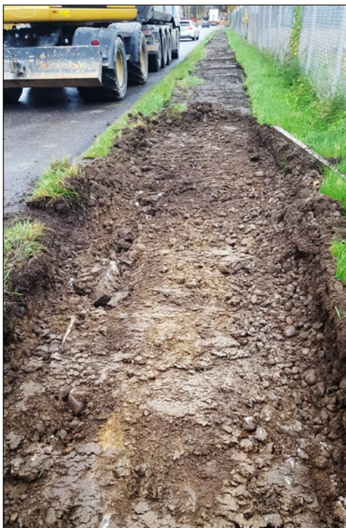
Figur 3. Vy över den södra änden av schaktet vid Kabelvägen. Längs med schaktet kan man se ett ljusare stråk. Det är ett kabelschakt som följer schaktet hela vägen. Foto från söder.
