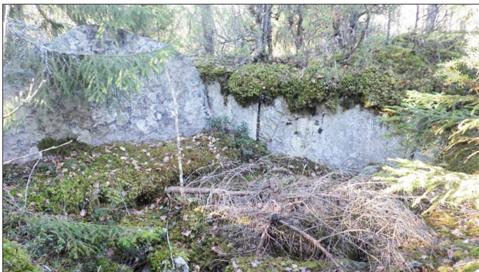
Figur 12. Skärpning (objekt 3) som påträffades på sydslutningen av en bergsrygg. Skärpningens sidor var lodräta med synliga borrhål i väggarna. Foto från sydväst.
