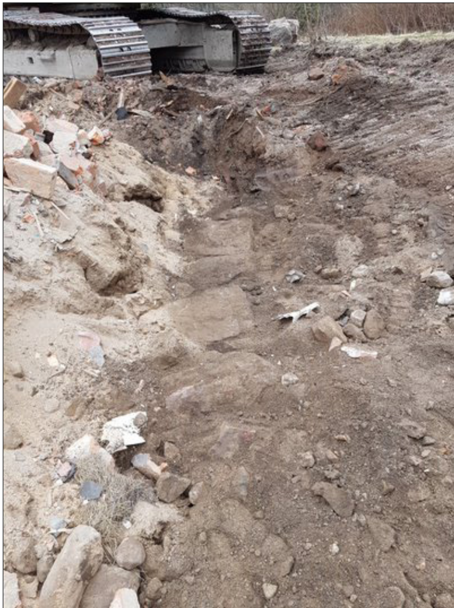
Figur 6. Äldre stensyll under rasmassor. Sett från nordväst.
