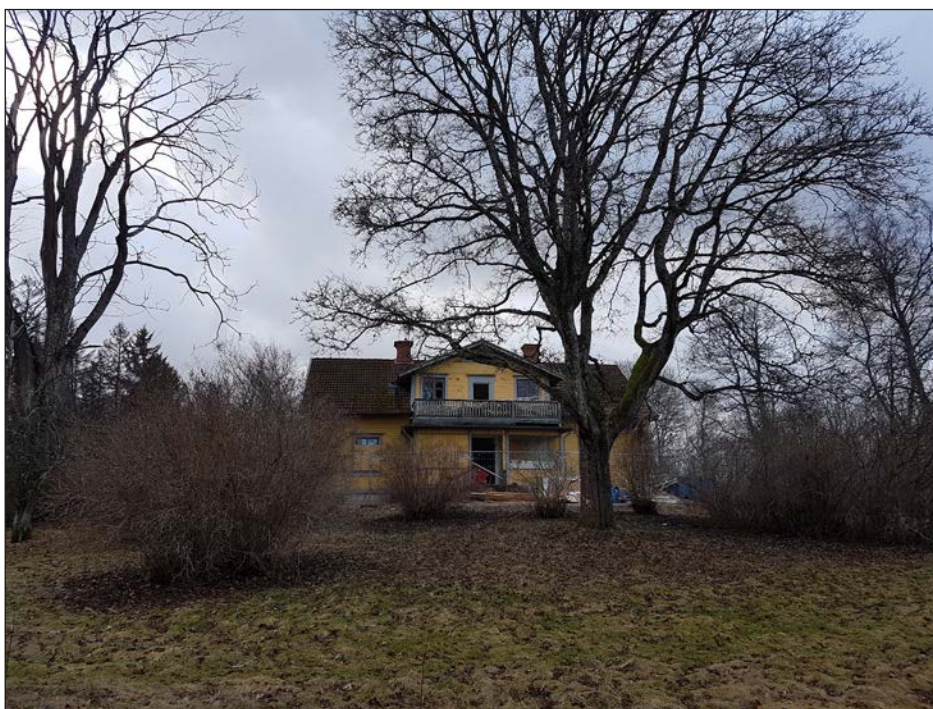
Figur 4 Mangårdsbyggnaden innan rivning. Sett från norr.
