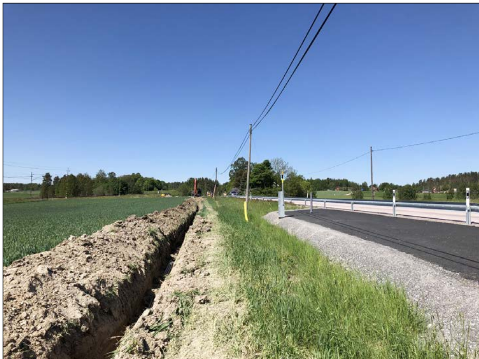
Figur 4. Schaktet (S1). Den asfalterade parkeringsfickan och markskåpet till höger i bild. Foto från öster.
