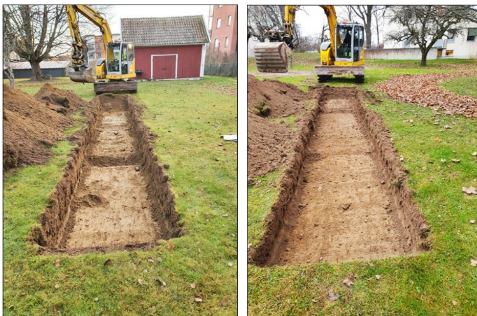
Figur 6a-6b) Exempel på schakt med sand eller grus i botten. Foto från norr.
