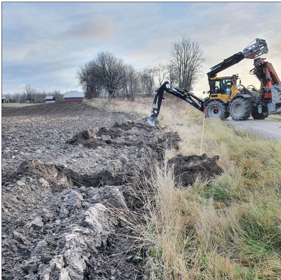
Figur 2. Schaktning för det planerade korsningsskyddet.
