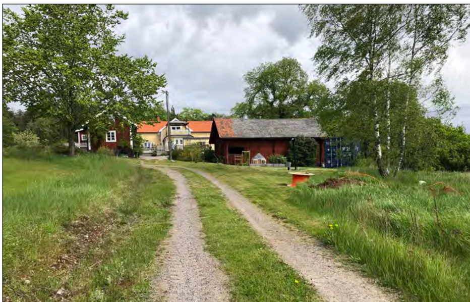
Figur 4. Schaktet grävdes fram till kabeltrumman. Foto från söder.
