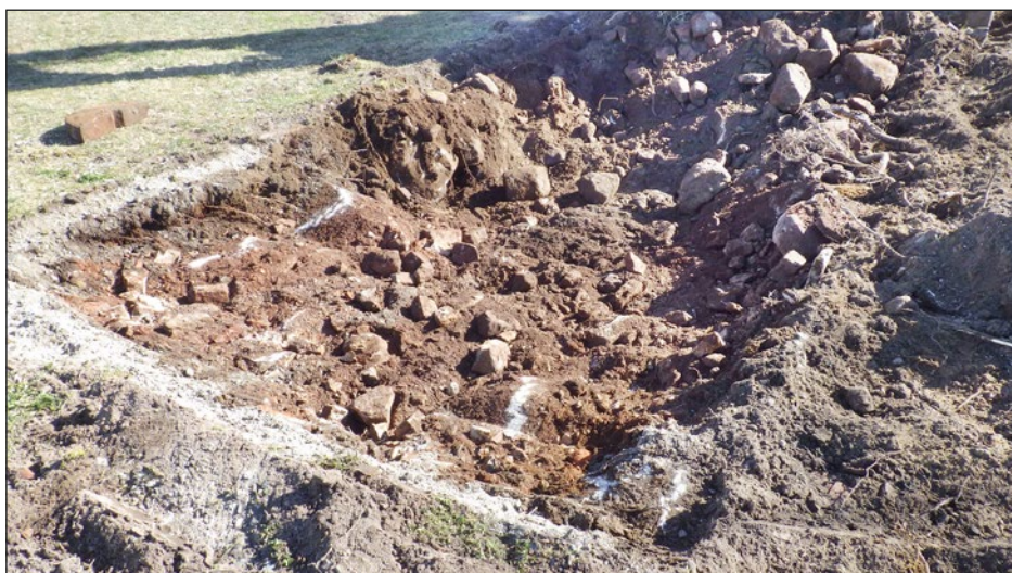
Figur 4. Sten- och blockfyllning i schaktets västra del.
