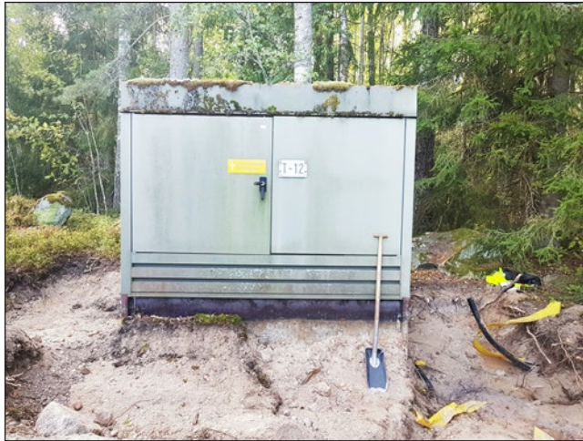
Figur 37. Schakt 5 som grävdes runt el-stationen. Foto från nordöst.
