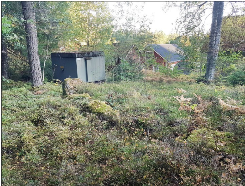
Figur 34. Elstationen, som skulle utbytas, belägen ett fåtal meter från treuddens ena nordvästra spets. Foto från sydöst.
