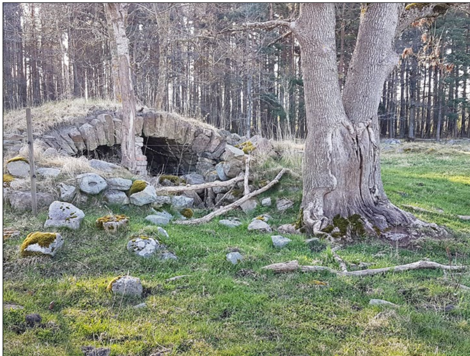
Figur 50. Valvslagen källare inom L1980:3353. Foto från väster.
