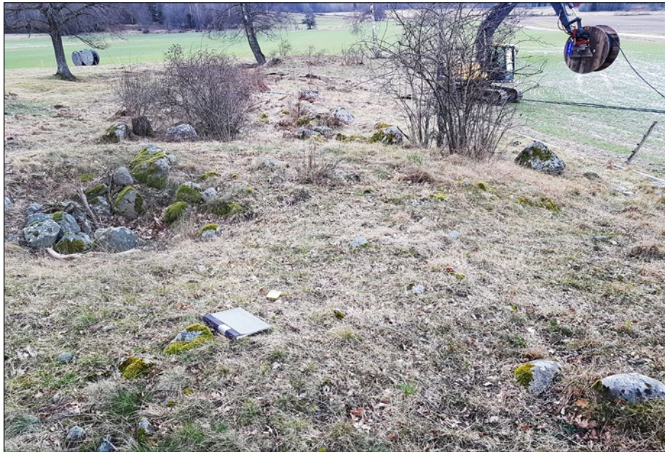
Figur 15. Vy från lägenhetsbebyggelse L1980:4462. I bakgrunden förbereder grävmaskin schaktarbetet söder om lämningsområdet. Foto från nordväst.
