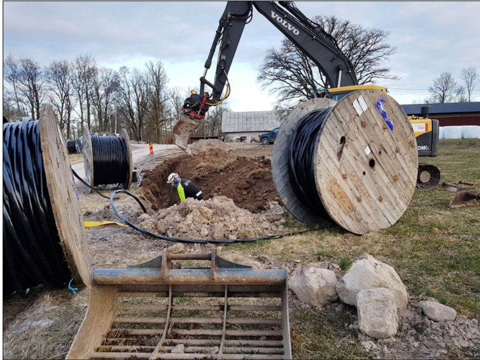
Figur 2. Schaktningsövervakning i samband med nedläggning av el-kabel, här vid Börsholm. Foto från söder.
