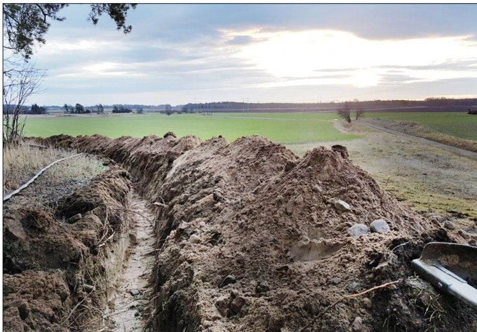
Figur 8. Vy över schakt invid boplat L1980:3803, där schaktet utgjordes av fin moränsand. Foto från väster.
