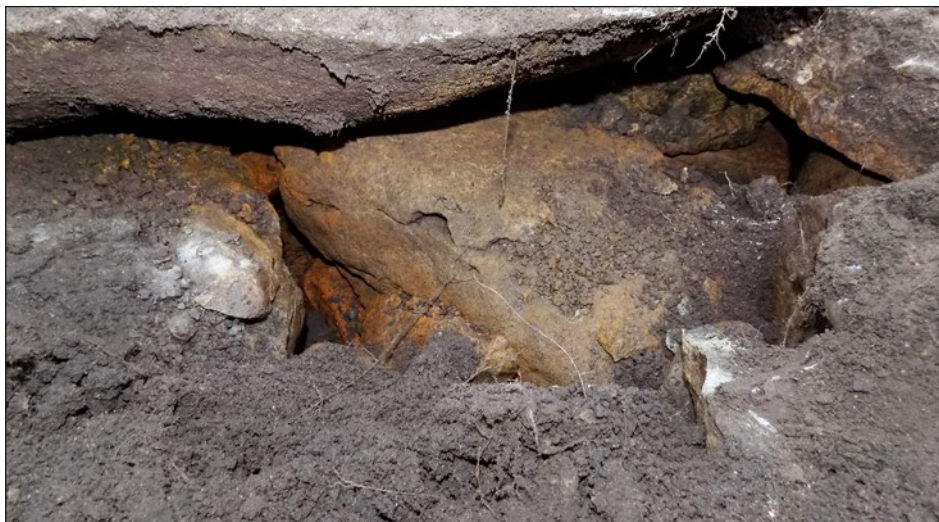
Figur 11. Ett smygfoto ner i stenfyllningen under den stora täckstenen (se föregående figur). Flera lager med stora stenar och ingen jordfyllning. Foto från väster.
