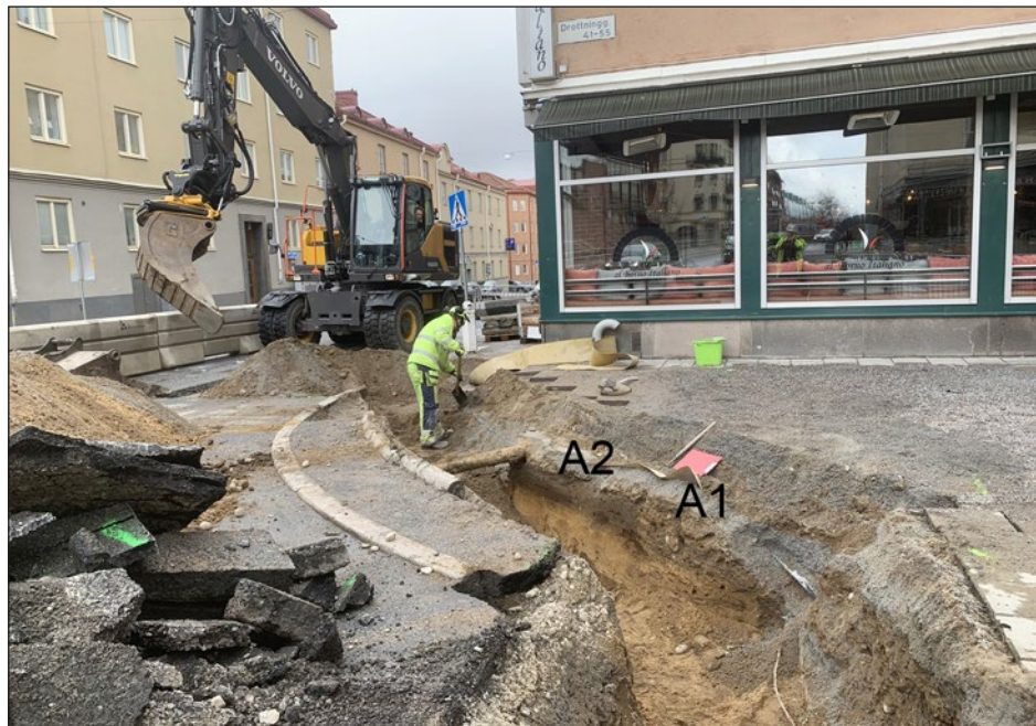
Figur 4. Lager A2 och nedgrävning A1 ses i schaktväggen. Foto från väster.
