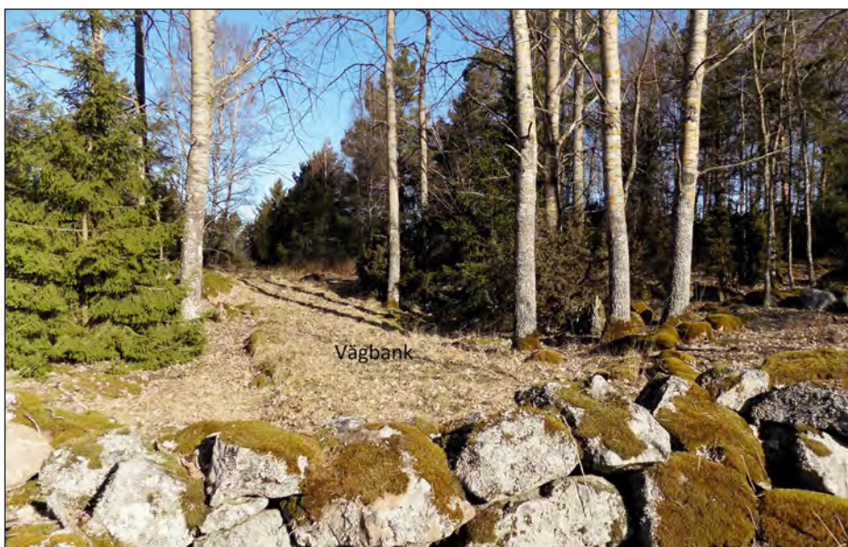
Figur 4. Del av den registrerade vägbanken. Sedd från söder. I förgrunden syns stenmuren som är byggd på vägbanken.
