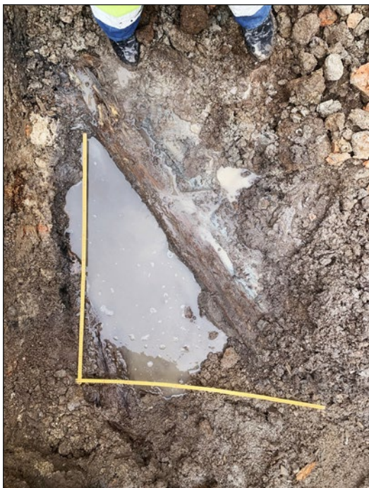
Figur 15. Lodfoto över den översta timmerstocken och lerpackningen. Schaktet fylldes snabbt med vatten.
