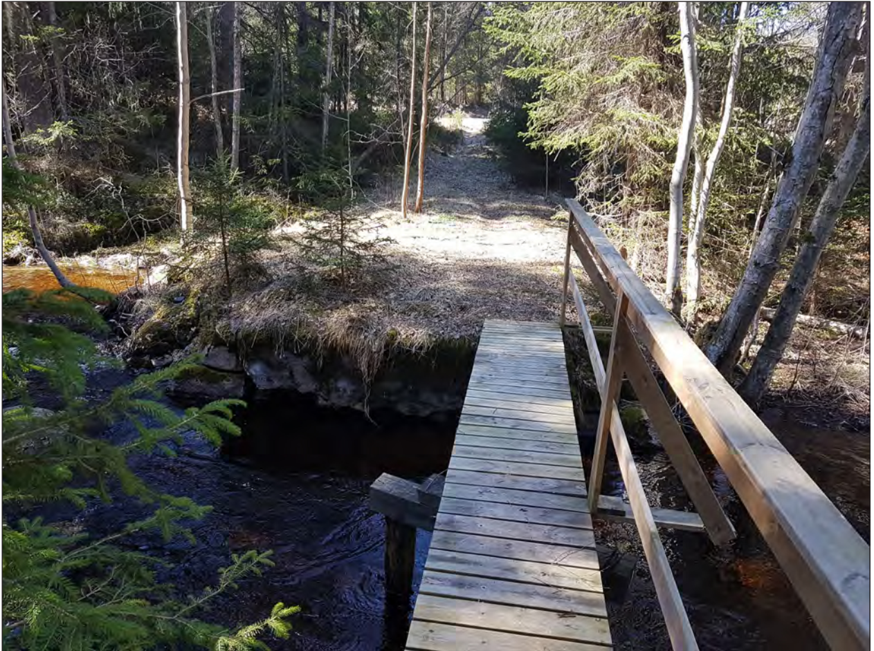
Figur 40. Det sydvästra brofästet (Objekt 18) vid Skomakartorp. Foto från nordöst.
