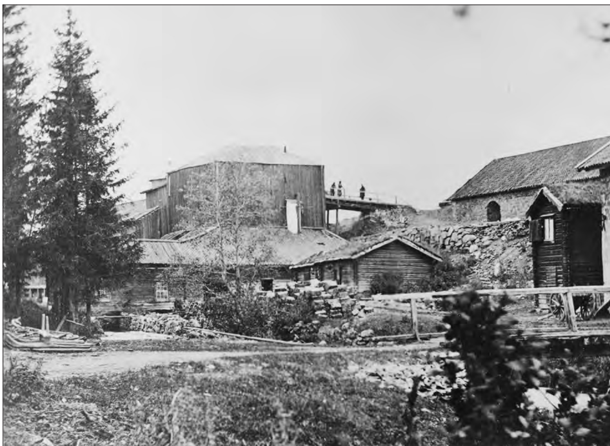
Figur 14. Fotografi över Hammarbackens masugn från sent 1860-tal med tillhörande bebyggelse (Tekniska museets arkiv). Den höga brådinklädda byggnaden är själva masugnen. Till höger om masugnen ses rampen varifrån kol kördes in och tippades ned i masugnen. Till vänster om masugnen ses ett hjulhus som är anlagt tvärs över vattendraget.
