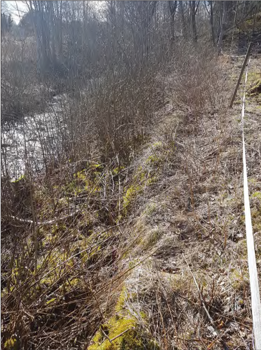
Figur 21. Längs vattendragets västra sida, norr om hyttområdet fanns en övertorvad terrasserad kant som utgör spår från hyttverksamhet. Dalgången var vattenfylld och vattenmagasinet nyttjades till att driva hyttans vattenhjul.
