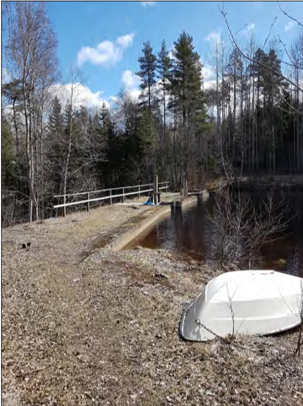
Figur 27. Gränsjöns damm, Objekt 11, sedd från sjösidan där dammkroppen utgörs av betong. Foto från nordväst.
