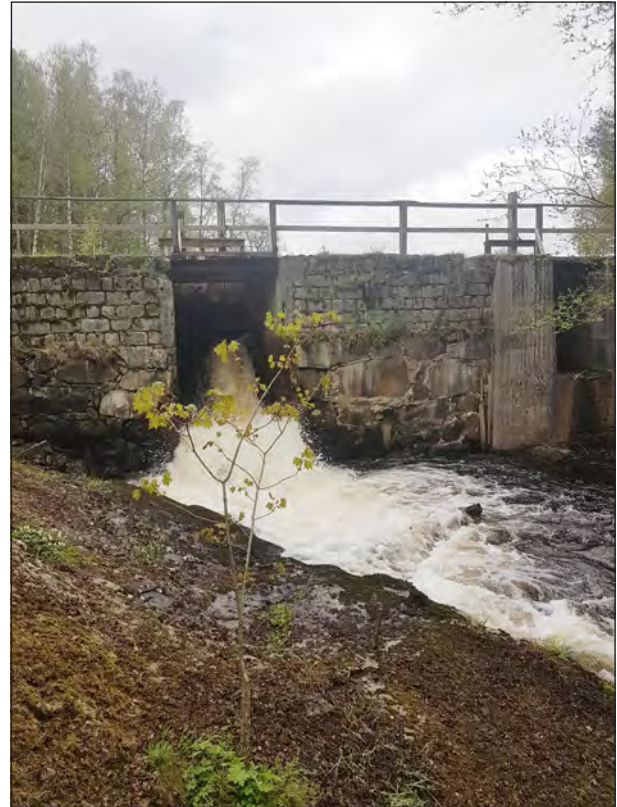
Figur 28. Gränsjöns damm, Objekt 11, sedd från Hammarbacksån varifrån dammens ursprungliga murning är synlig. Dammen är anlagd i två nivåer med en gråstensmur nederst och sinnersten överst. Foto från nordöst.
