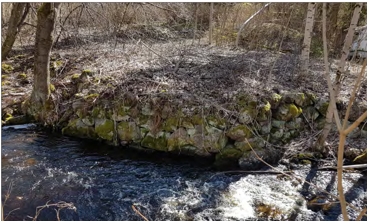
Figur 32. Det sydöstra brofästet hörande till Objekt 13. Kallmurade brofästen. Foto från nordväst.
