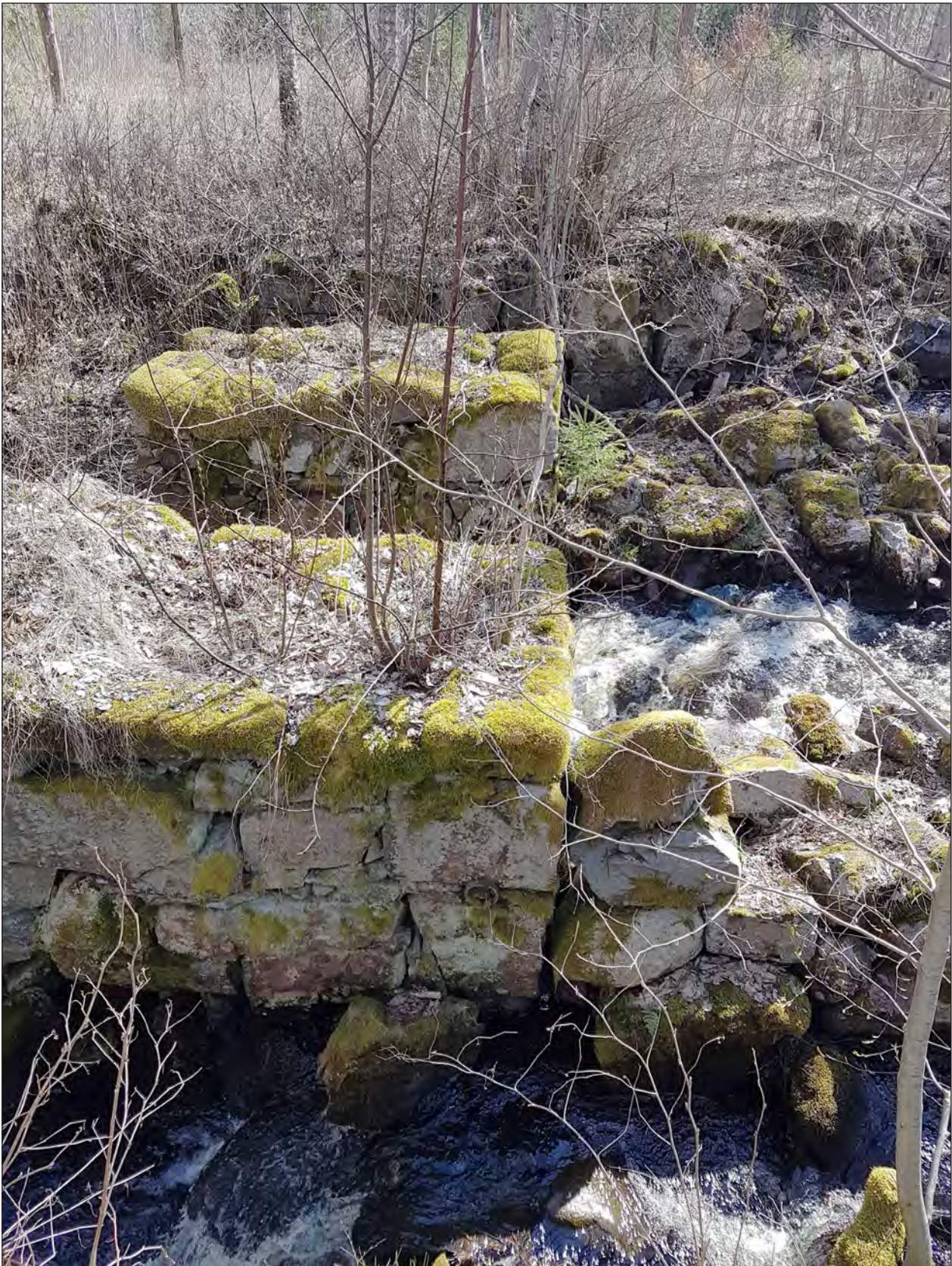
Figur 36. Dammens mittpelare inom Objekt 16. Foto från nordväst.
