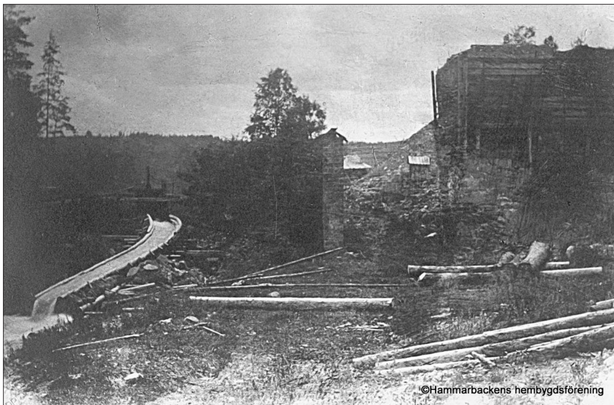
Figur 29. Hyttområdet sedd från nordöst. En timmerränna har anlagts för att leda timmer ned till Hammarbacksån, sannolikt på grund av det höga fallet, och för att även leda timmer ned till ytterligare en ränna (Objekt 17).
