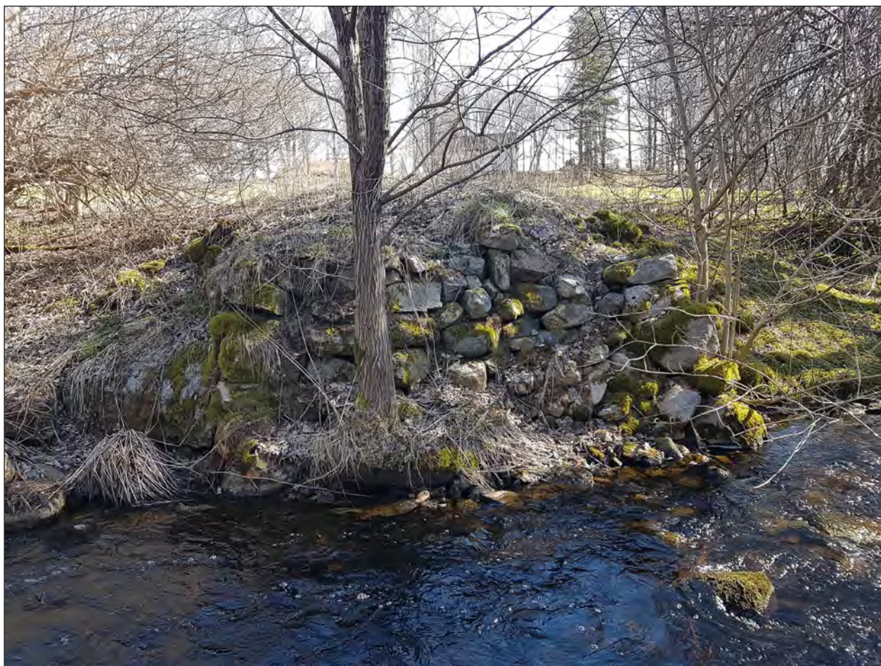
Figur 23. Det nordöstra brofästet hörande till Objekt 6. Foto från sydväst.
