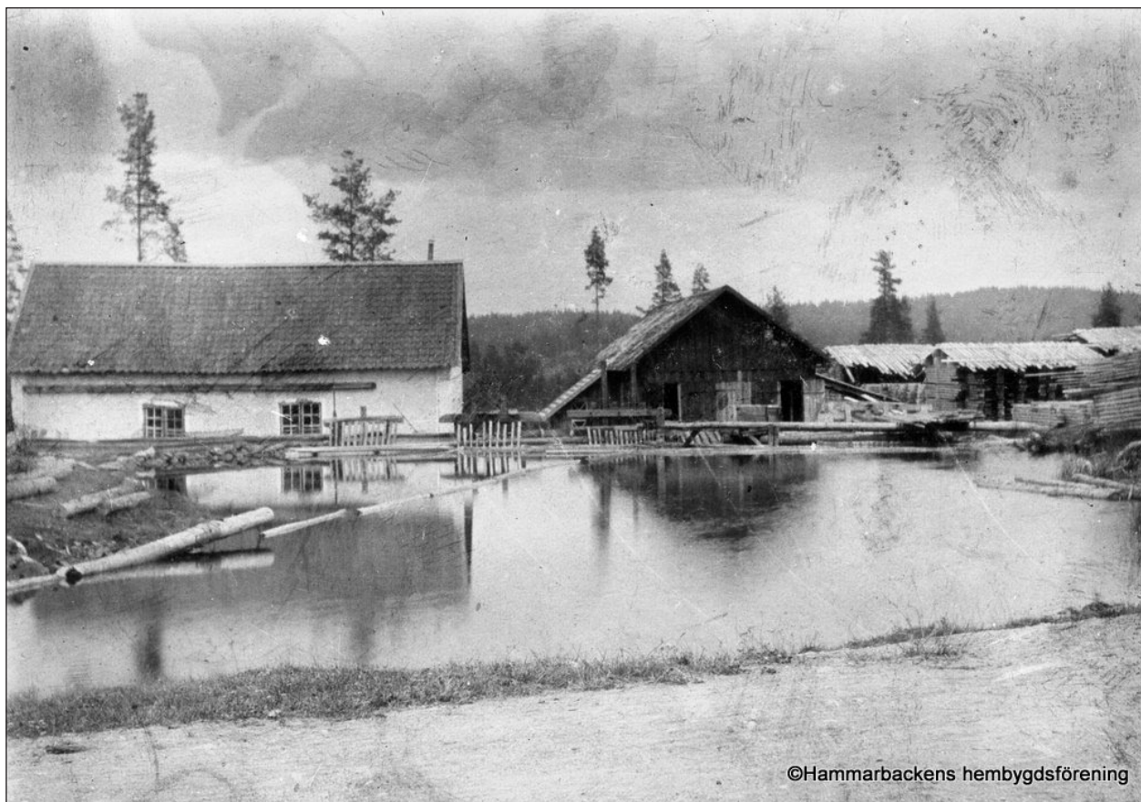
Figur 15. Vy över kvarn-och sågområdet från sent 1890-tal (Hammarbackens hembygdsförening). Kvarnen är den vitrappade byggnaden till vänster med sågen till höger i bild. I bildens främre del ses dammens tre spettluckor och vattenmagasin som nyttjades vid drift av anläggningarna.
