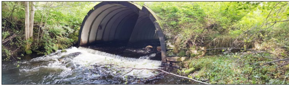
Figur 9. Innan åtgärd. Vägtrumma och stödmurar (A106) på nedströmssidan. Stödmurarna visar på enhetlig murning och har med största sannolikhet uppmurats efter det att vägtrumman anlagts. Ett synnerligen omfattande schaktarbete bör ha föregått vägtrummans anläggande varvid den tidigare dammen förstörts men dess stenar återanvänts till stödmurarna. Foto från sydöst.
