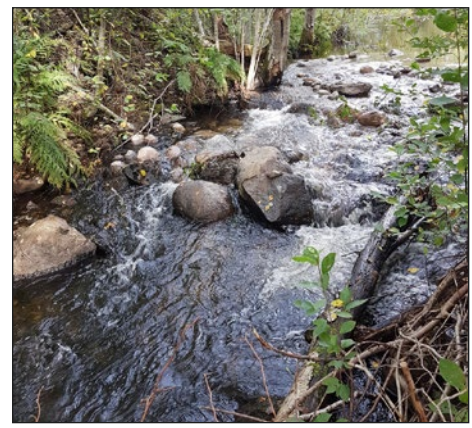
Figur 15. Efter åtgärd. Vattendraget vid bron har fyllts ut med stenmaterial. Foto från sydöst.
