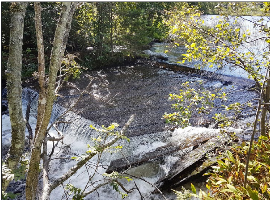
Figur 20. Innan åtgärd. Foto över skibord sett från nordväst.
