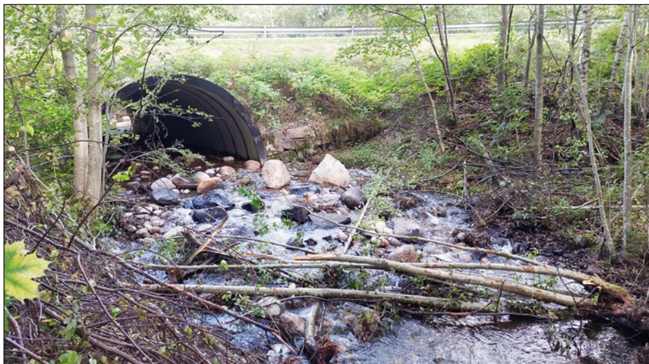
Figur 10. Efter åtgärd. Vattennivån har höjts medelst utfyllnad av grus och stenmaterial. Stödmurarna är ännu väl synliga. Foto från söder.
