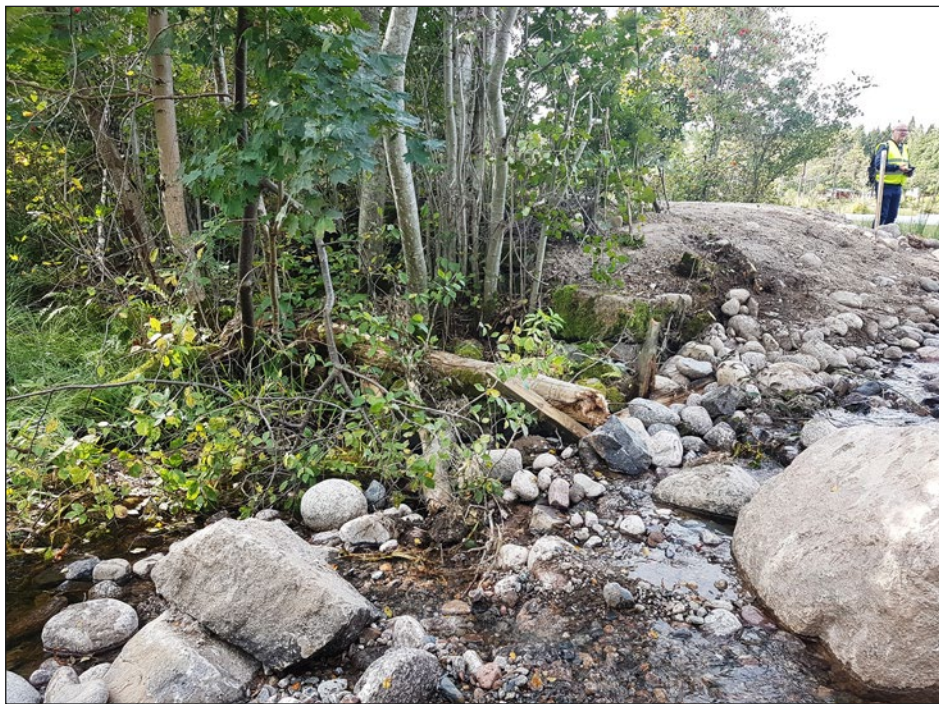
Figur 23. Efter åtgärd. Utfyllnadsmaterial (sten) har lagts emot norra änden av strandskoningen till dammvallen (L1980:9954). Foto från nordöst.
