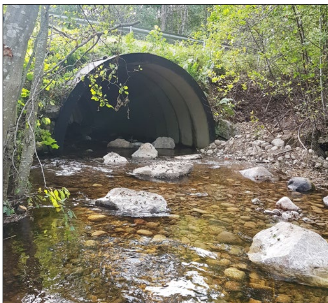
Figur 13. Efter åtgärd. Vägtrumman på uppströmssidan. Utfyllnadsmaterial har tillförts inne i vägtrumman och uppströms. Stödmuren, synlig till höger om vägtrumman, har täkts av grusmaterial. Foto från nordöst.
