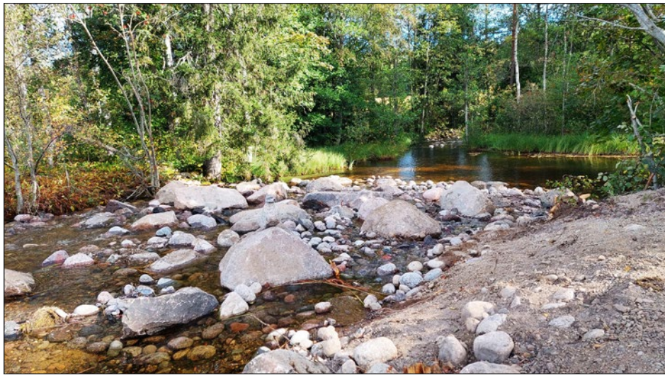
Figur 22. Efter åtgärd. Dammkroppen riven och ersatt med ett självreglerande flöde. Foto från sydväst.
