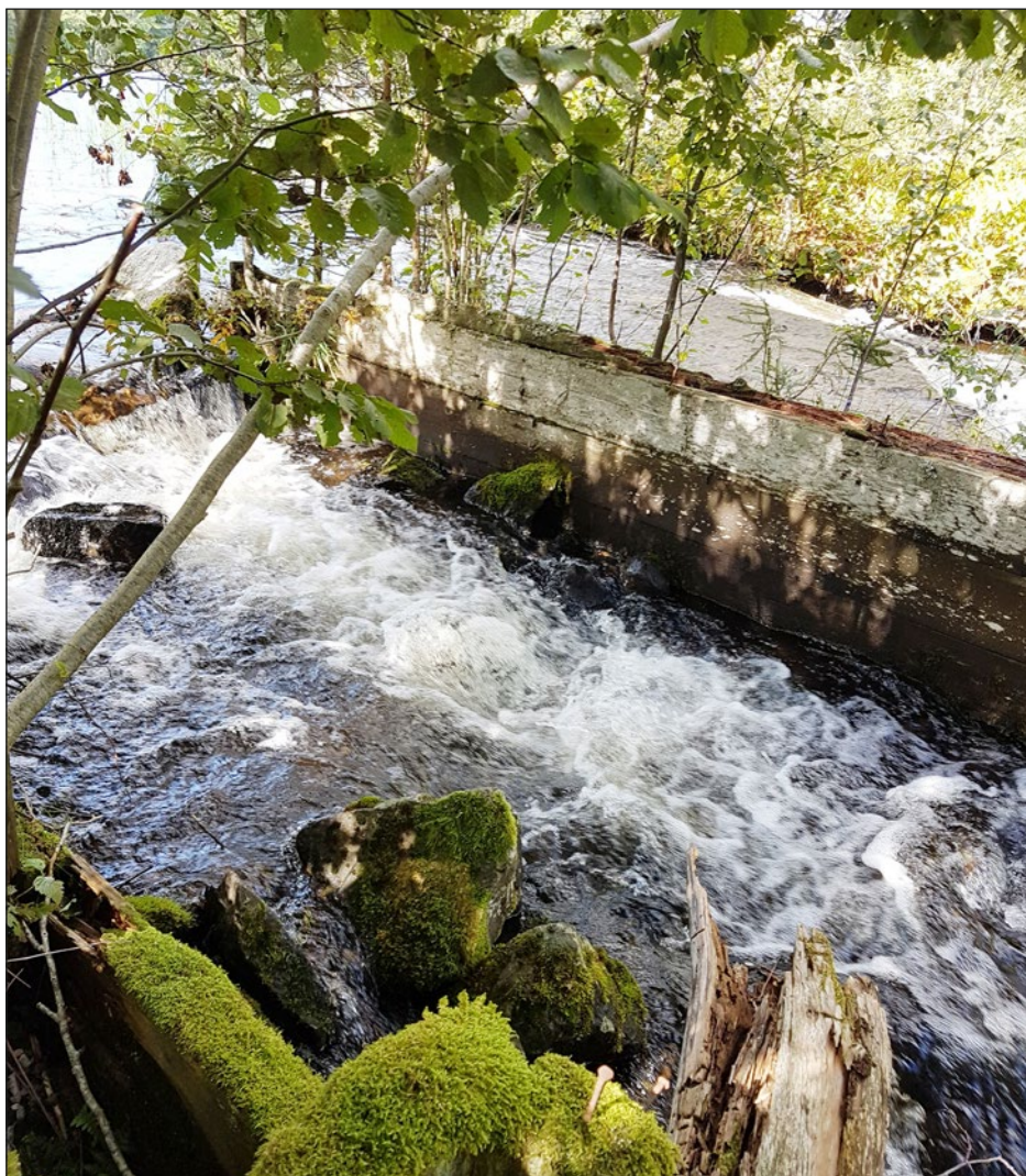
Figur 21. Innan åtgärd. Dammöppningen sedd från sydöst. Spettluckan är inte kvar och älven har fritt flöde genom öppningen.
