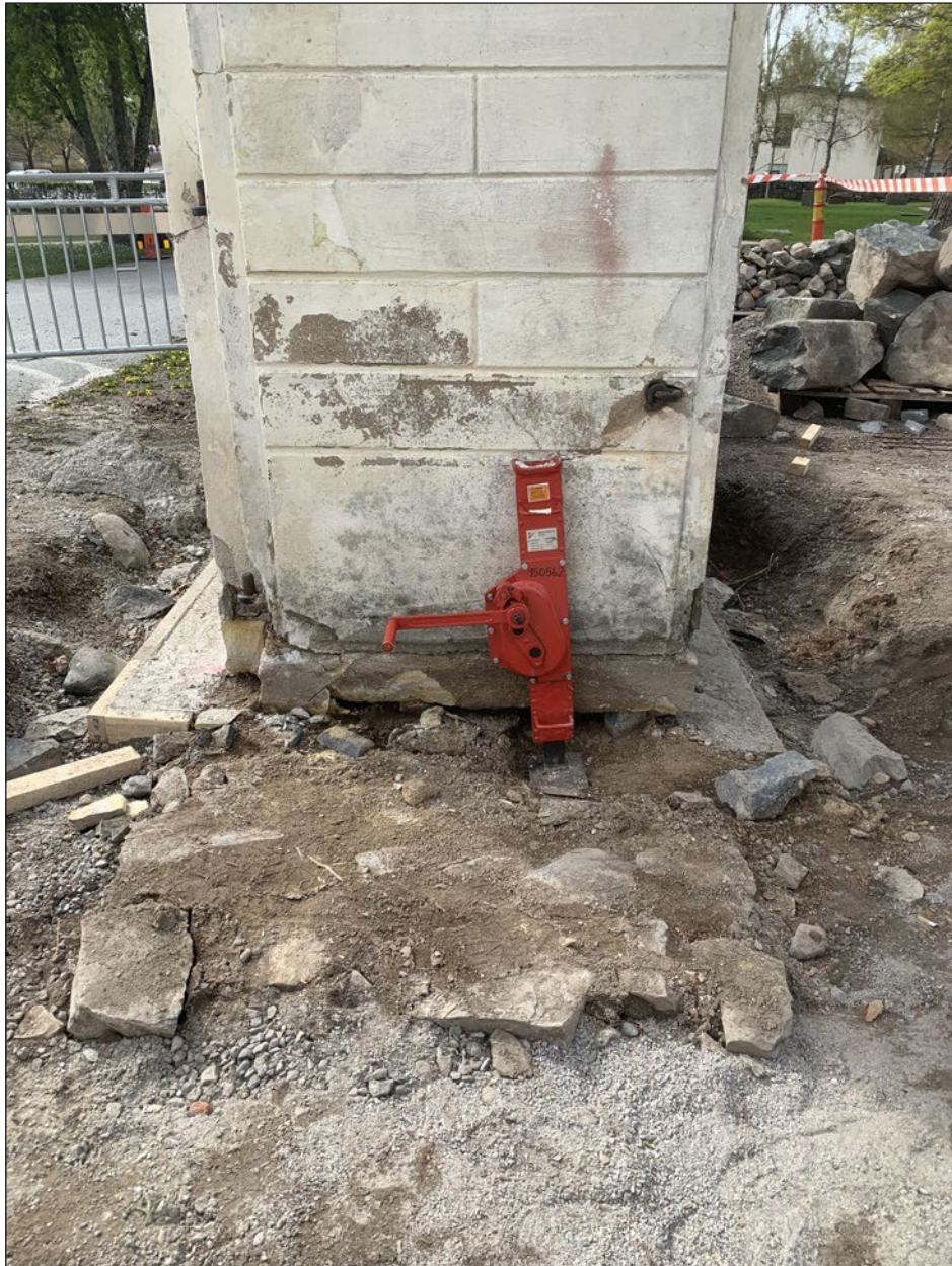
Figur 6. Flytten av grindstolpen är genomförd.
