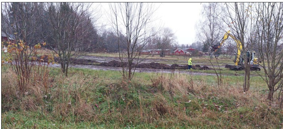
Figur 6. Översikt från sydväst på ytans norra del. Schaktgrävning pågår.
