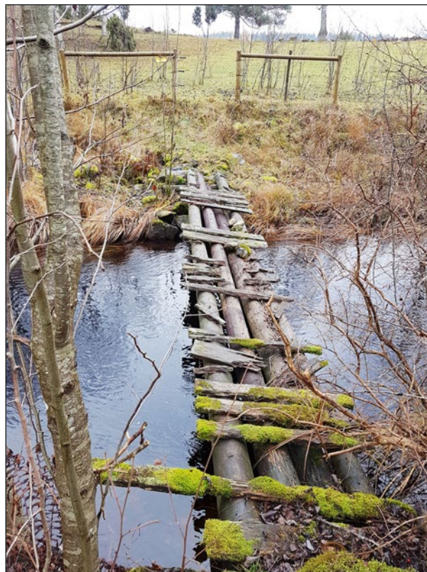
Figur 47. Bro (objekt 9) utgörs av träspång anlagd på brofästen av sten. Foto från nordväst.
