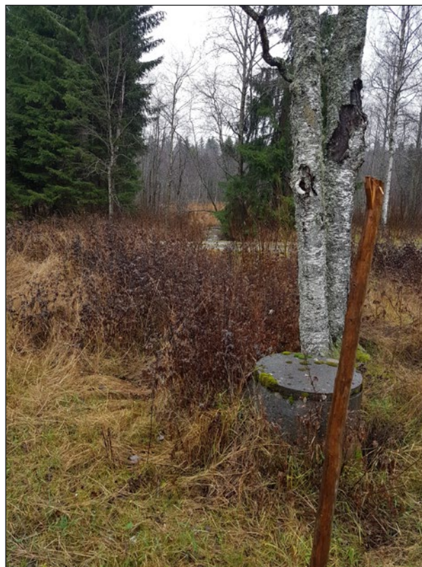
Figur 66. Källan (objekt 17) utgörs numera av en betongtrumma med dike ut i Venaån. Foto från väster.
