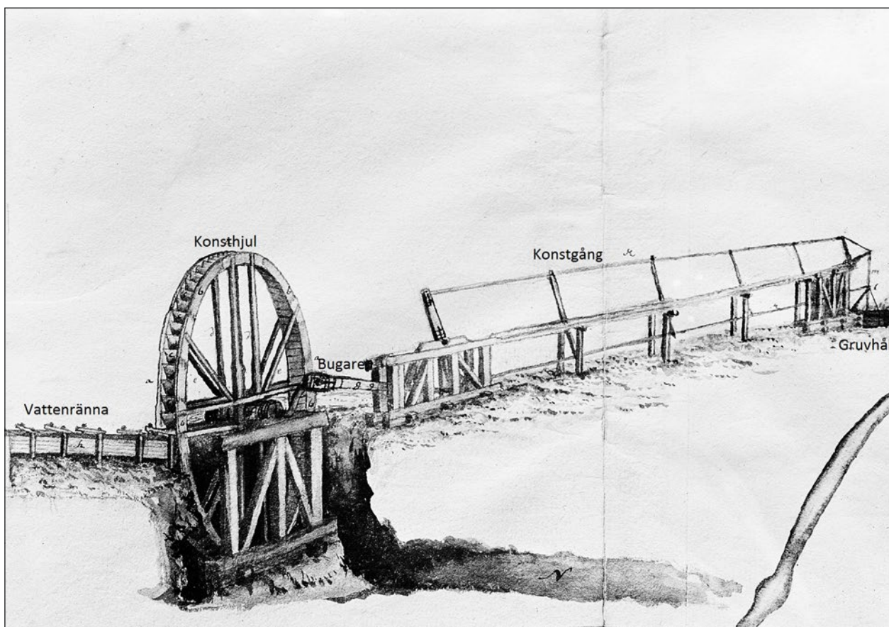
Figur 63. Vattenränna, konsthjul och konstgång från 1710, Sala, Västmanland. En vattenränna förser ett konsthjul med vatten varvid hjulet sätts i rörelse, Konsthjulets vertikala rörelseenergi överförs till horisontell energi, via en bugare, till konstgången som rör sig i en pendlande rörelse. I konstgångens ände, vid gruvhålet, finns en hiss- eller pumpanordning som forslar upp malm eller pumpar upp vatten. Av Johannes Ranie (Jernkontoret).
