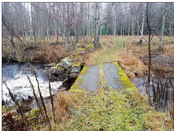
Figur 58. Dammvallens (objekt 15) östra landfäste med betongbron. Foto från väster.
