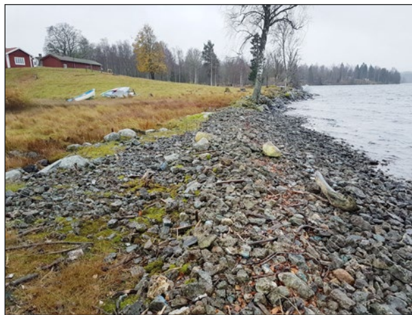
Figur 31. Dammvallen (objekt 1) sedd från dess norra ände. Vallen utgörs av en konstgjord udde av utfyllda massor med slagg. Foto från norr.
