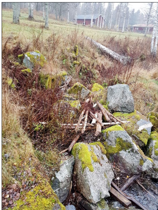
Figur 59. Dammvallens västra landfäste utgörs av utrasade stenar och konstruktionsdetaljer till separat öppning till konstkanalen saknas. I bilden ses en nedfallen björk ligga i konstkanalen. Foto från sydöst.
