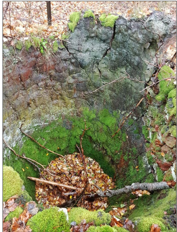
Figur 34. Av masugnen syns numera enbart pipan i form av ett instängslat hål i slänten, sedan övriga delar täckts över med jordmassor. Foto från sydväst.
