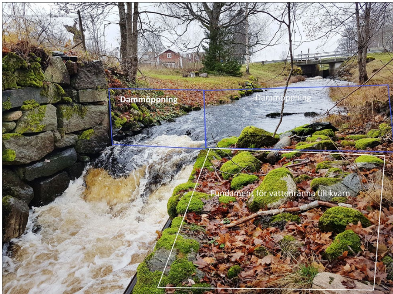
Figur 40. Dammvall (objekt 5) sedd från öster. Lägen för tidigare dammluckor är markerade tillsammans med fundament. I dammöppningens norra del har dammlucka funnits som släppt fram vatten till en träränna som vilat på fundamentet.
