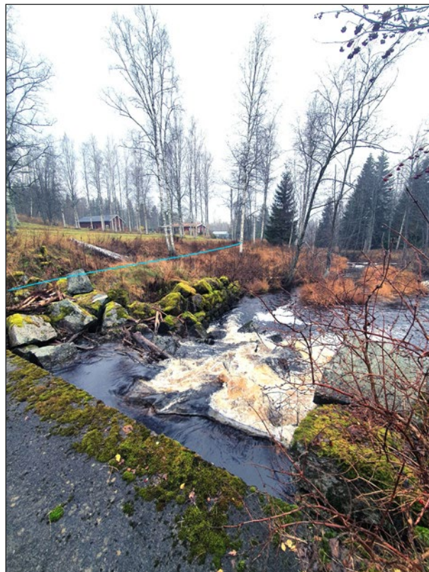
Figur 60. Vy över utloppet vid dammvallen (objekt 15). Läge för konstkanalen (objekt 16) markeras med blå linje. Öster om kanalens jordvall finns en kallmurad stödmur längs västra strandkanten. Foto från sydöst.
