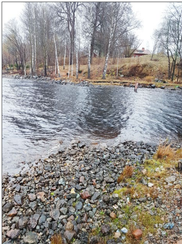
Figur 30. Älvlångens utlopp i Venaån där tidigare en hålldamm varit belägen. Dammen revs under 1950-talet. Foto från söder.
