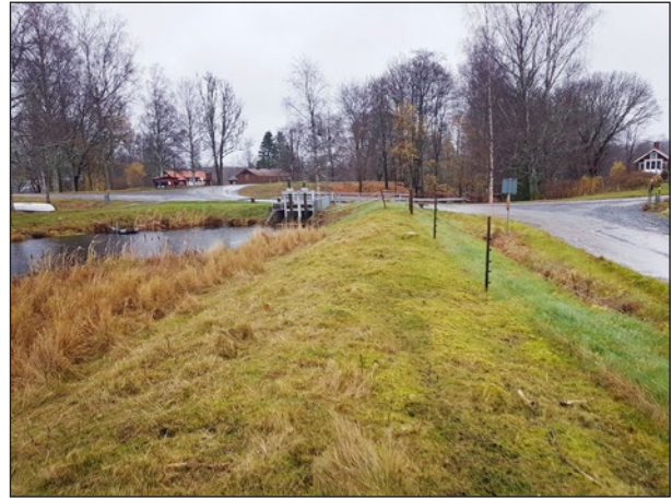
Figur 32. Modern dammvall (objekt 2) som anlades under 1950-talet. Dammen har ingen koppling till den historiska vattenverksamheten i Älvhyttan. Foto från väster.
