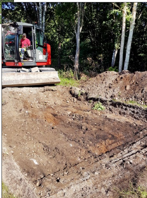
Figur 8 (t.h.). Schakt S113 sett från söder. Schaktet färdiggrävt. I samtliga schakt utgjordes den naturliga undergrunden av rostfärgad grusig morän med inslag av 0,1 meter stora stenar.
