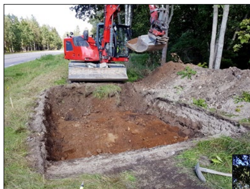
Figur 8 (t.h.). Schakt S113 sett från söder. Schaktet färdiggrävt. I samtliga schakt utgjordes den naturliga undergrunden av rostfärgad grusig morän med inslag av 0,1 meter stora stenar.
