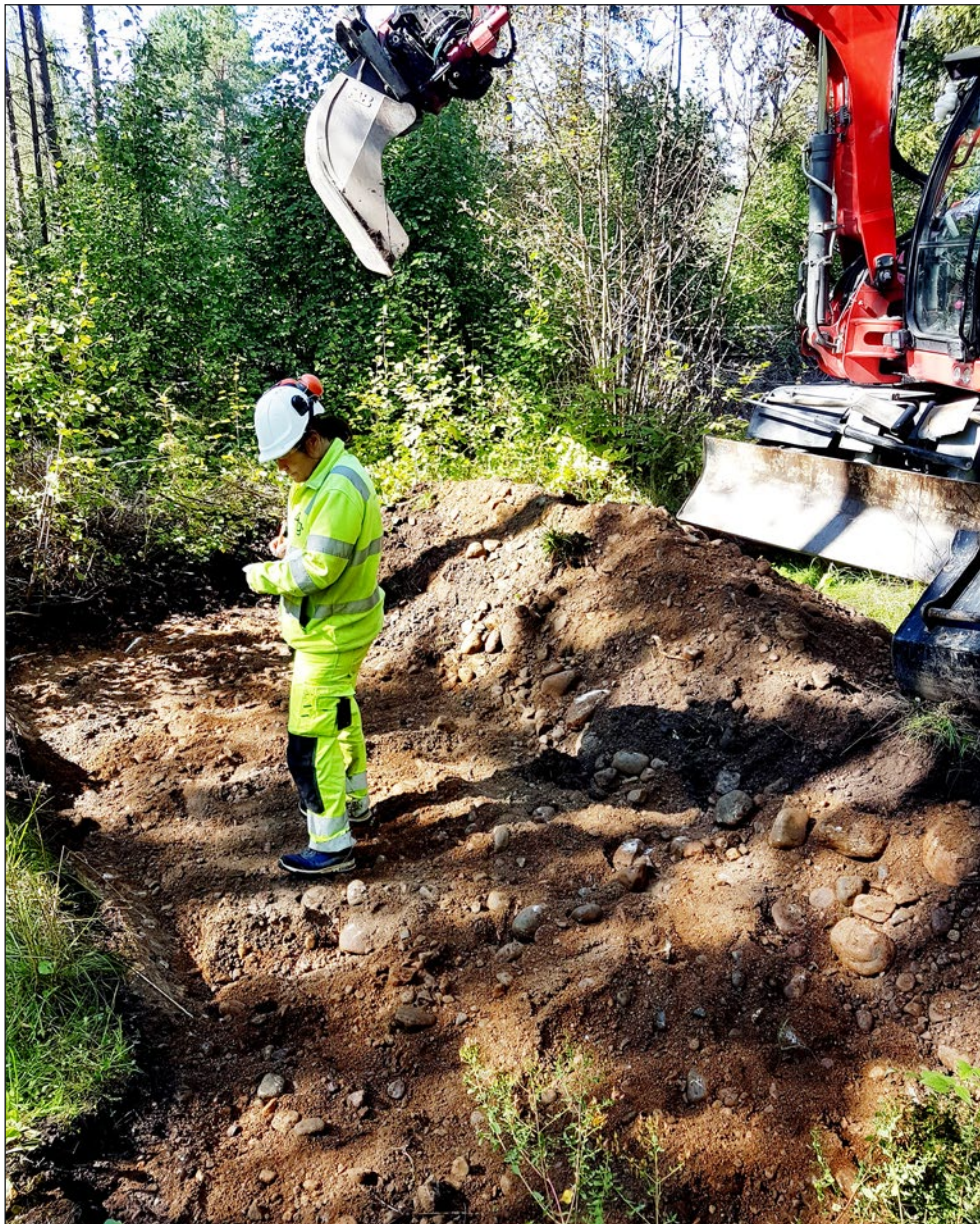
Figur 13. Schakt S114 är färdiggrävt och dokumenteras av Erica. Lagerföljden utgjorts av torv följt av ett tunt skikt av den äldre vägbanan som överlagrade naturlig morän. Foto från nordöst.
