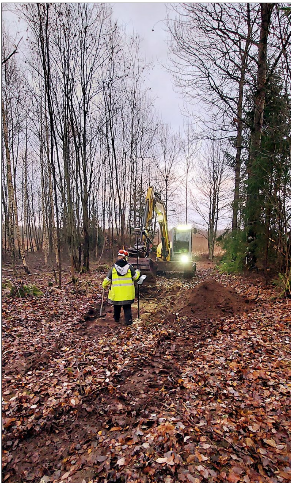
Figur 2. Schaktning i skogspartiet. Foto från väster.
