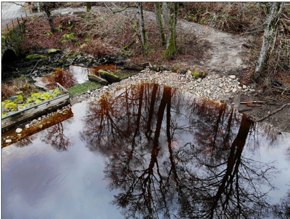
Figur 17. Skyddande vall framför grunddammen. I dess övre skikt utgörs vällen av ett lager grus- och sten. Foto från norr.
