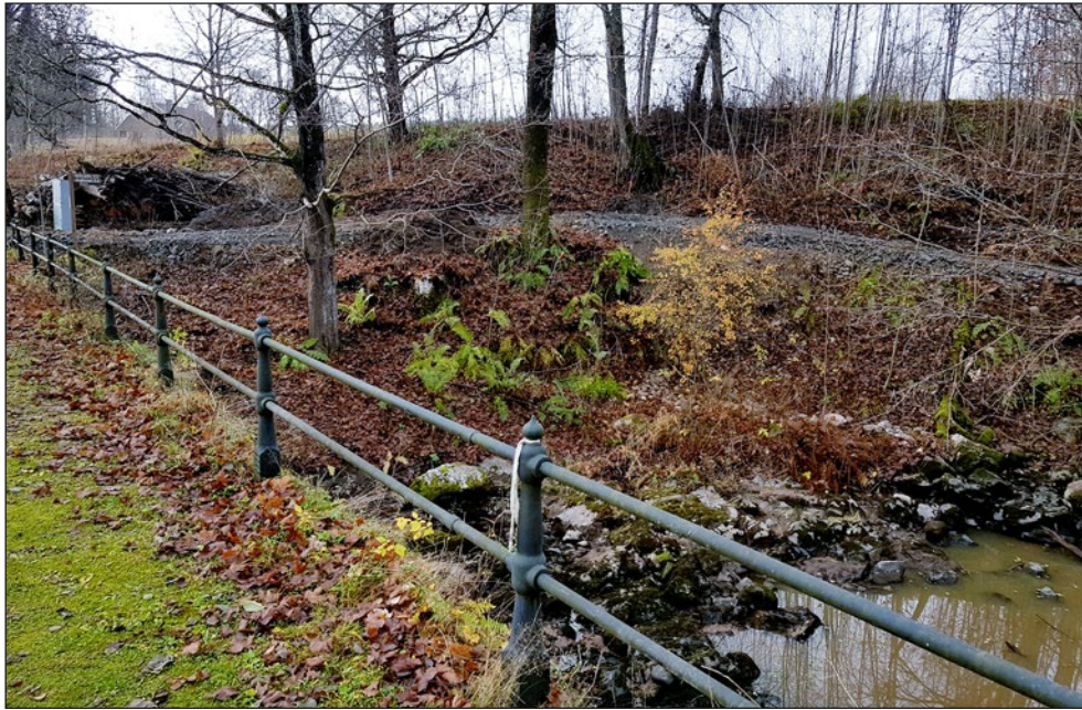
Figur 21. I samband med åtgärdsarbetet anlades en provisorisk körväg av grovt stenmaterial på stigen. Foto från nordöst.
