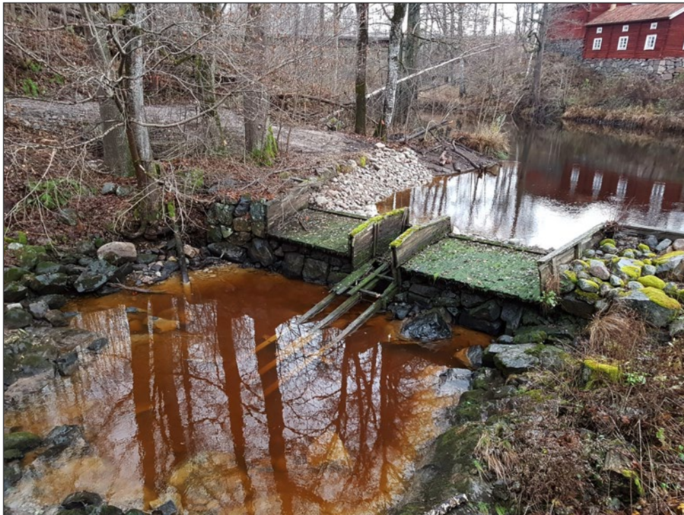
Figur 18. Grunddammen sedd från sydväst.
