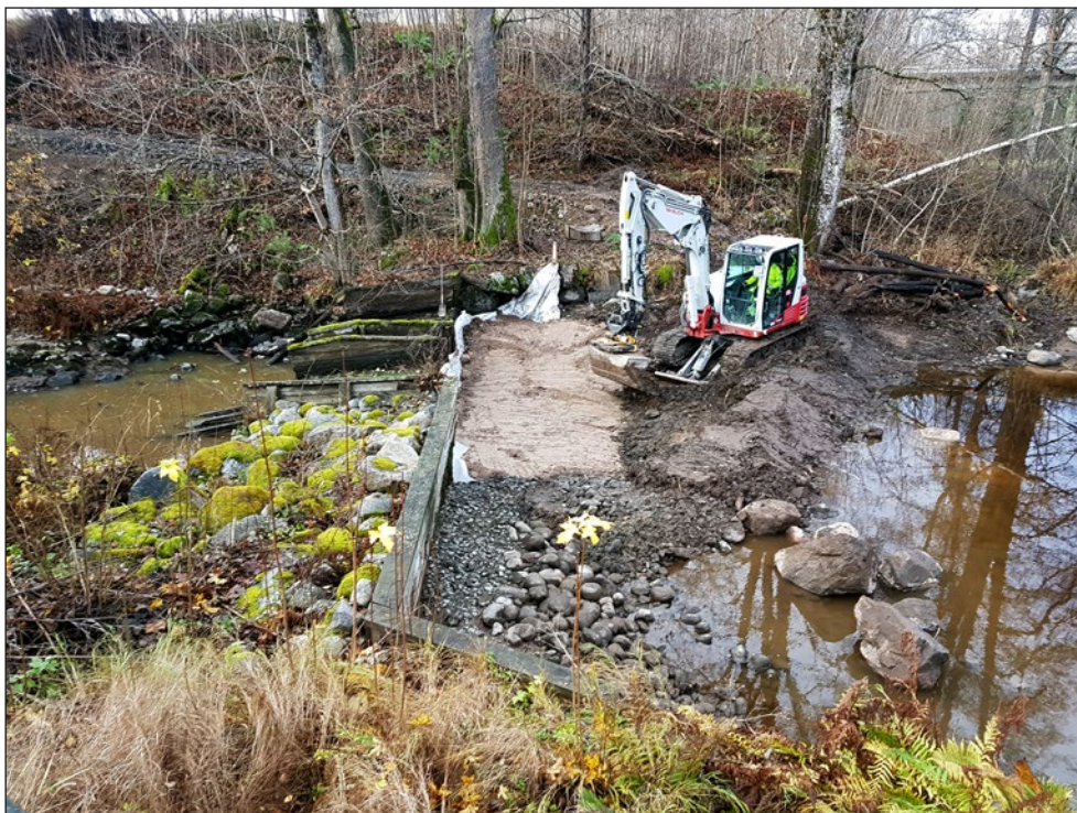
Figur 16. En grävmaskin står på jordvallen och arbetar med att packa jord framför grunddammen. Foto från öster.
