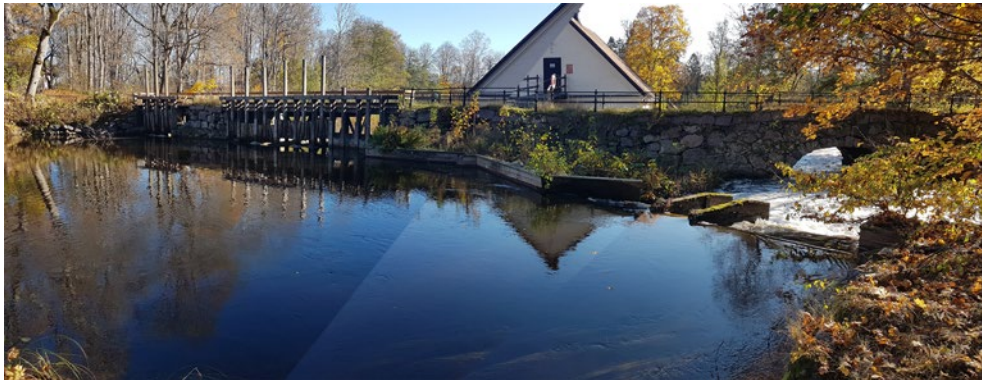
Figur 5. Panoramavy över dammanläggningen vid Järle. Till höger i bild syns grunddammens överfallsvärn med stenvalvsbron nedströms. Foto från sydväst.
