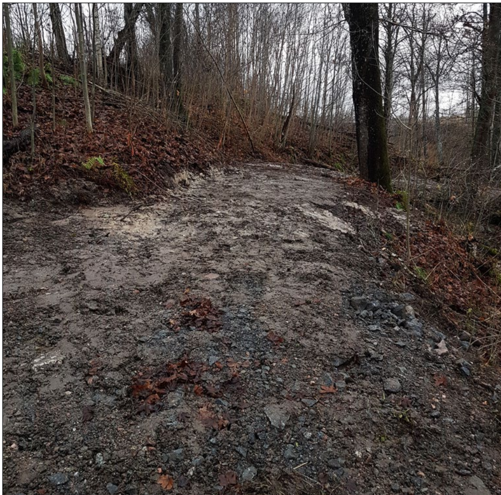
Figur 22. Efter utförd åtgärd grävdes det provisoriska gruslagret bort och marknivån planades ut i syfte att återställa stigen.
