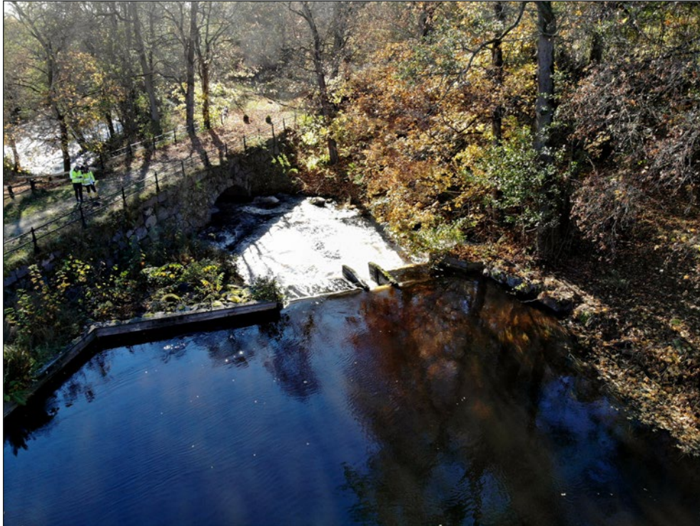
Figur 3. Vy över grunddammen sedd från uppströmssidan, innan utförd åtgärd. Foto från norr.
