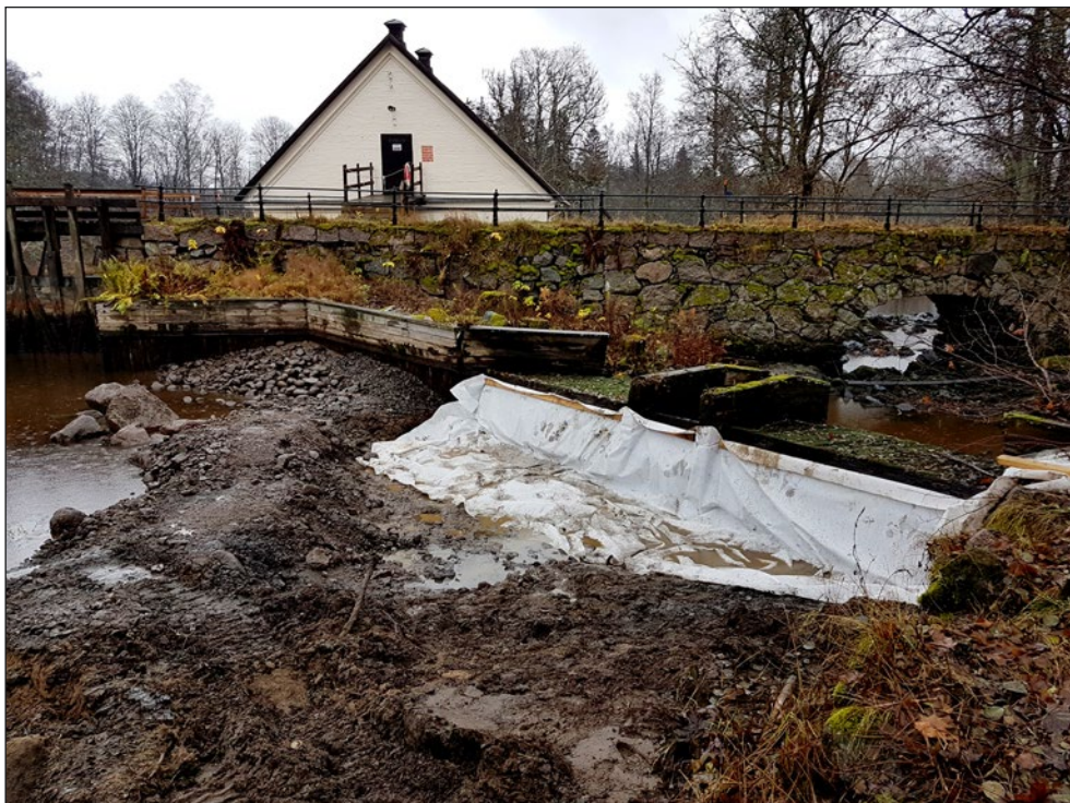
Figur 15. Till vänster i bild har en skyddande jordvall anlagts i syfte att möjliggöra arbetet framför grunddammen. Grunddammen har klätts in med fiberduk. Foto från nordväst.
