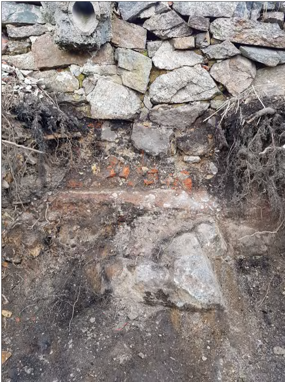
Figur 17. Handgrävning i källaren A178. Foto från ingången i söder.
