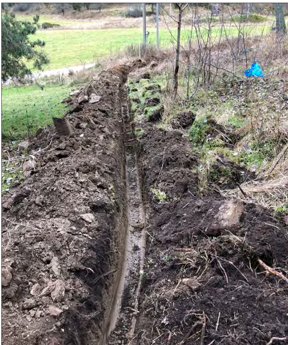
Figur 4. Färdigschaktat! Foto från slänten i nordöst.
