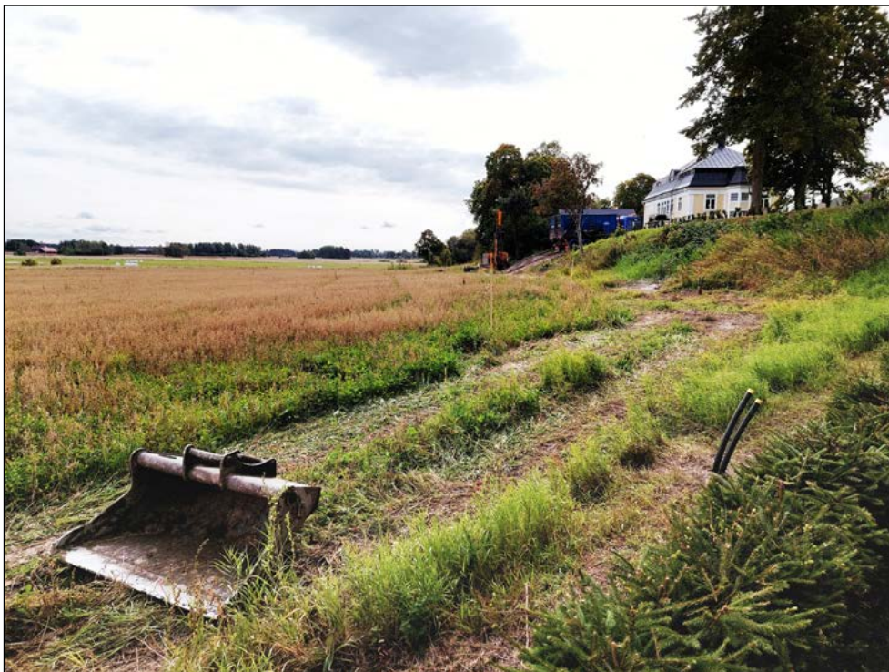
Figur 6. Området för det östra schaktet i åkern före schaktnings början. Foto från nordnordväst.
