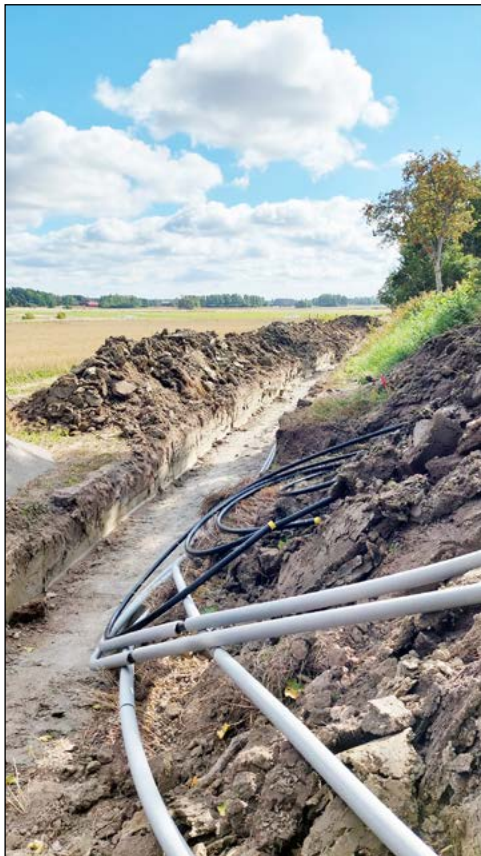
Figur 7. Schaktet i åkern uppgrävt med kablarna färdiga att placeras på plats. Foto från nordväst.
