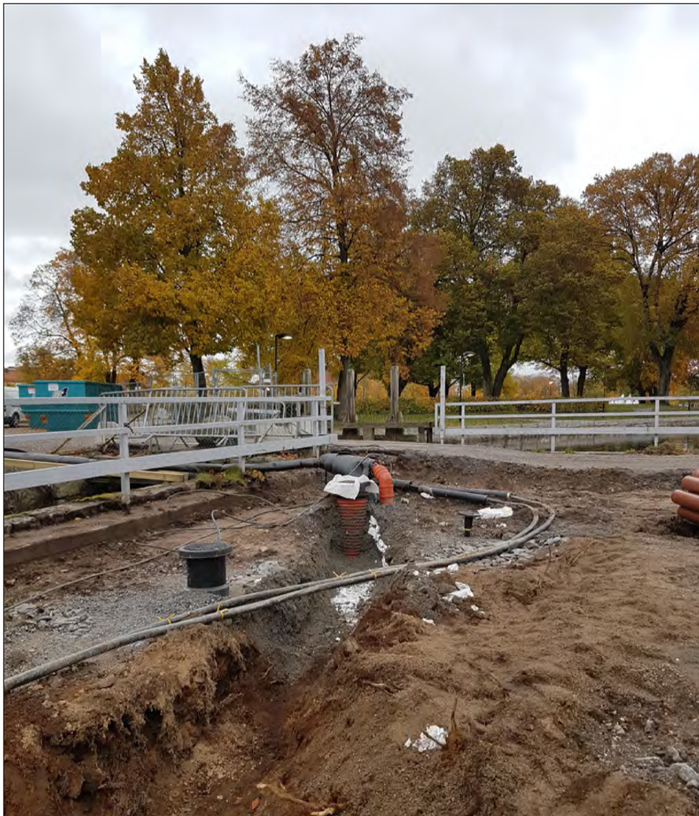
Figur 9. Grävning pågår av dagvattenschaktet.
