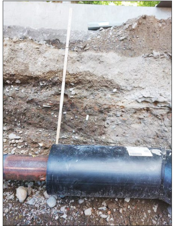
Figur 6. Foto som visar bärlagren under gatan Esplanaden med de nylagda fjärrvärmerören i förgrunden. Platsen för kritpipsskaftet är markerad med vit fyndpinne.
