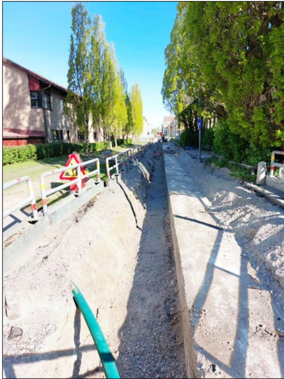
Figur 5. Foto som visar delsträcka 2 med delar av betongkulverten till höger i bild. Foto från sydöst.
