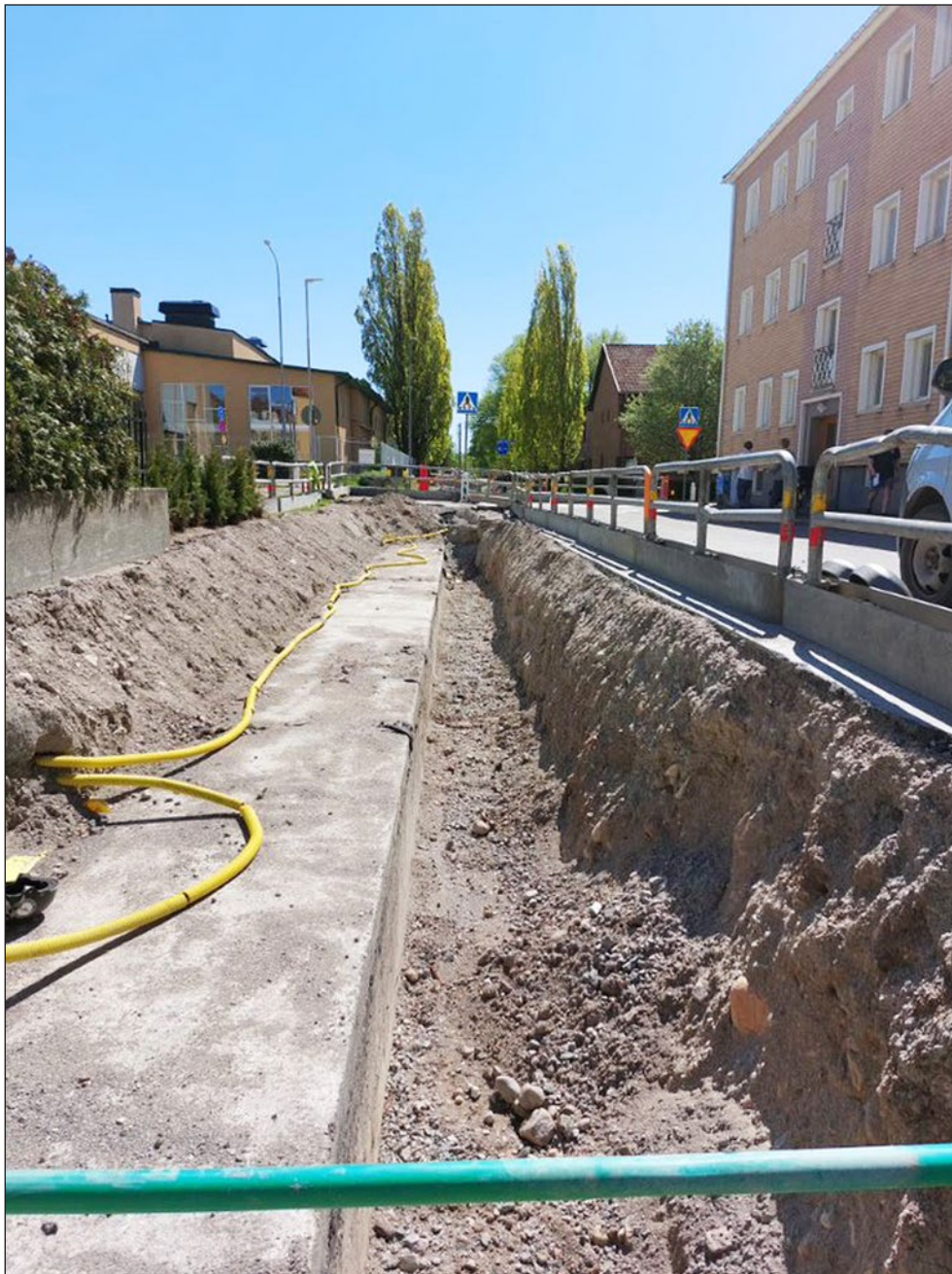
Figur 4. Foto som visar gruset på botten och bärlagren i den sydvästra schaktkanten inom delsträcka 1. Fotot illustrerar även betongkulverten innan demolering. Foto från nordväst.
