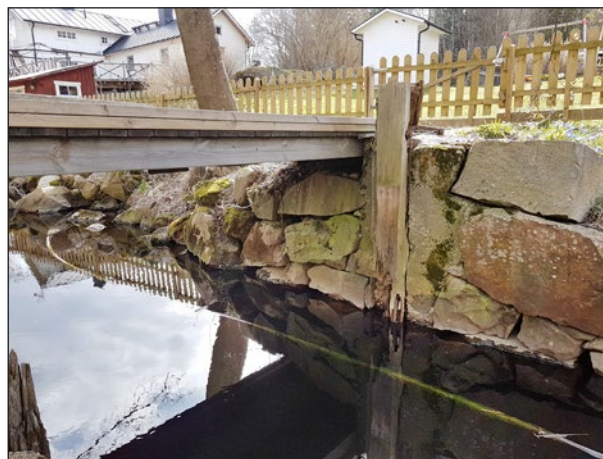
Figur 49. Sydöstra sidan av dammen. Den kallmurade dammkroppen utgörs delvis av betong, bland annat med gåtspår med bevarade rester efter dammluckan i form av träreglar. Foto från väster.
