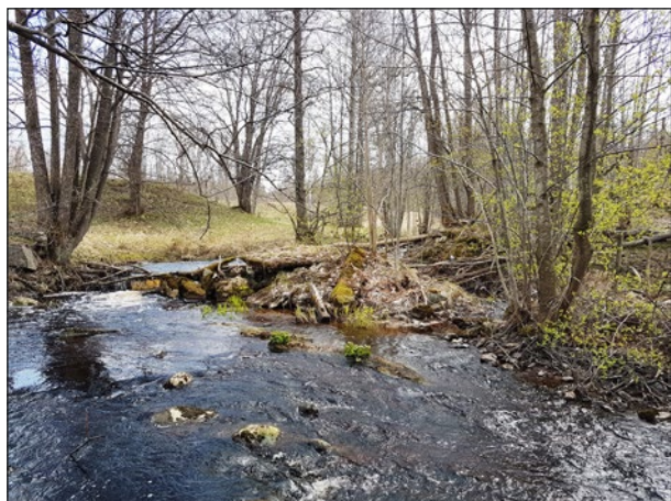
Figur 37. Dammvall (objekt 15) sedd från väster. Den norra dammöppningen är vattenförande medan den södra är något högre belägen och utgjordes möjligen av en överfallsöppning.
