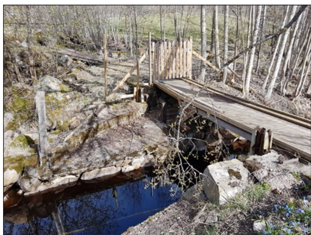
Figur 48. Hålldammen (objekt 23) från sydöst. Dammkroppen är välbevarad men dammluckan borttagen. Numera finns en träspång anlagd på dammkroppen.
