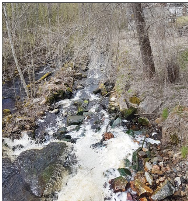
Figur 23. Vy från norra dammluckan varifrån vattnet, ursprungligen leddes in i hjulhuset nedströms via en träränna. Kvar av hjulhuset är dess grunder i form av ett fundament i vattendragets mitt och strandskoning i norra stranden. Foto från öster.
