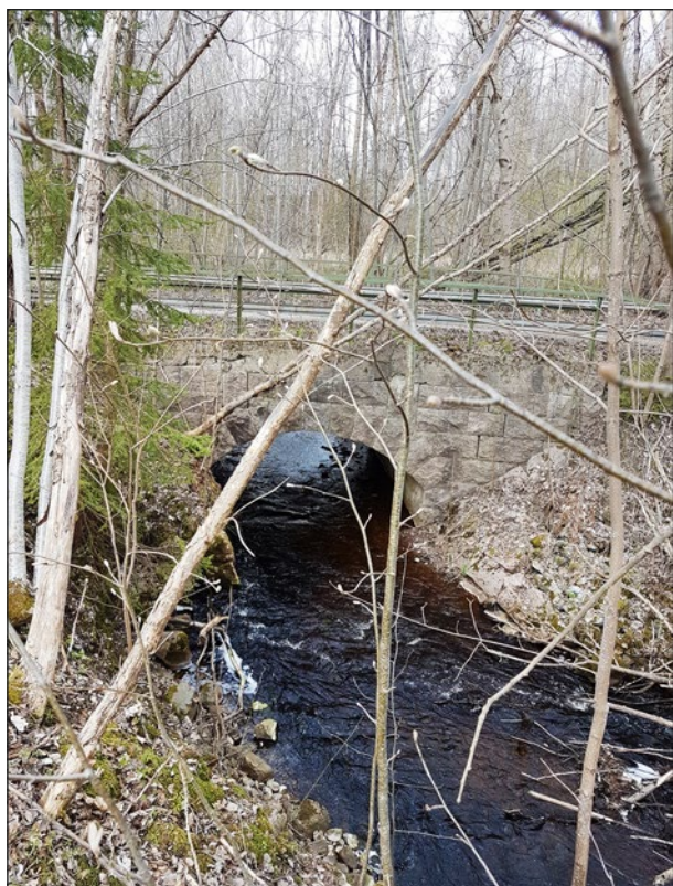
Figur 34. Sentida stenvalvsbro som kom att ersätta den äldre landsvägsbron (objekt 9). Foto från öster.
