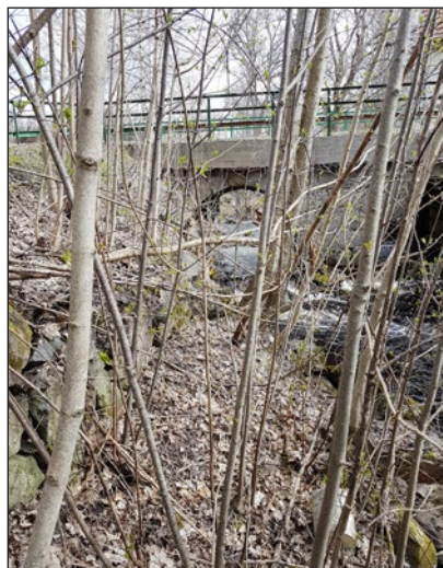
Figur 43. Plats för ränna som utgått från dammbrons norra valv (objekt 21). Till vänster i bild ses del av terrasserad mur. Rännan har varit placerad till sydöst (till höger i bild) om muren. Foto från sydväst.
