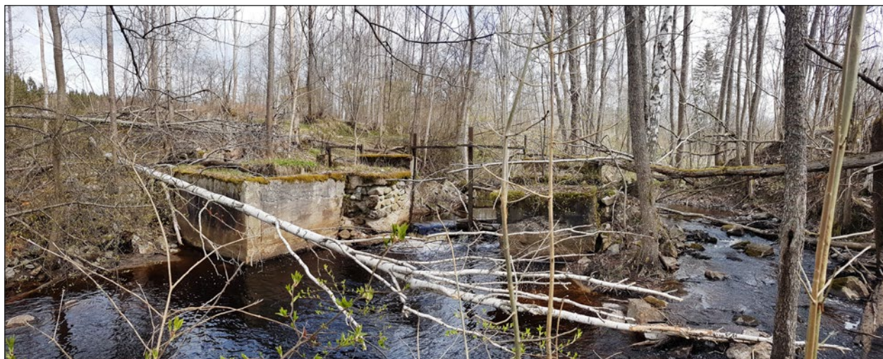
Figur 30. Panoramavy över dammen till tegelfabriken (objekt 7) sedd från väster. I bildens högra del syns den södra dammvallen vara avgrävd med ett omlöp runt de tidigare dammluckorna till höger i bild. I dammens norra del finns två dammluckor, dels till turbinrum, dels regleringslucka i vattendraget.
