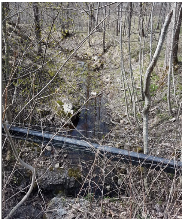
Figur 40. Grävd ränna (tidigare objekt 18) som ledde vatten till såg- och raffelstoppsfabrik. Foto från nordöst.
