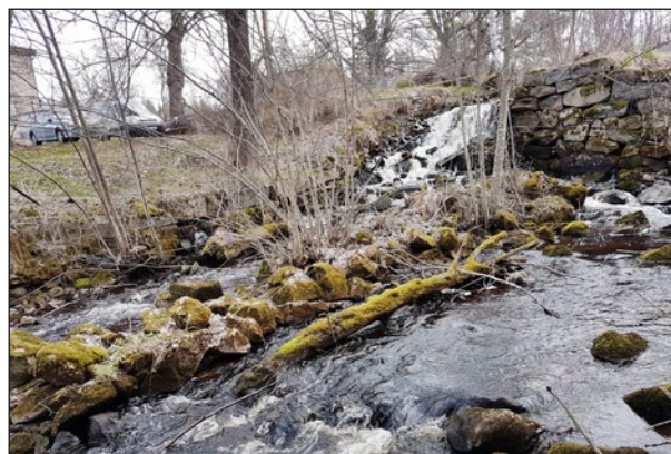
Figur 24. Norra dammöppningen med rester av hjulhusets nedströms i form av ett fundament i vattendraget och stenskonig vid norra stranden. Foto från sydväst.
