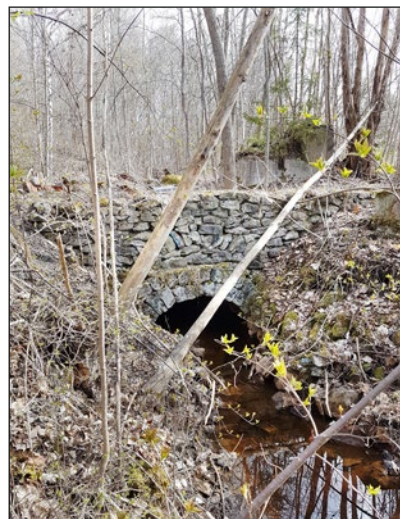
Figur 45. Utlopp för kulverterad ränna som sannolikt varit kulverterad från hjulhuset. På marken ovanför kulverteringen syns del av byggnad med betongrester. Foto från sydväst.
