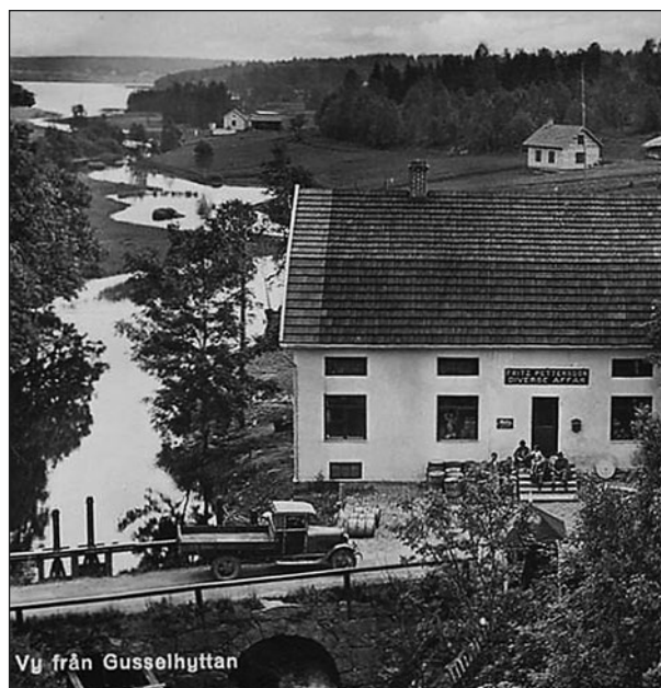
Figur 47. I fotografiets nedre vänstra hörn syns dammbron (objekt 21). Vid det norra valvet syns två spetluckor på uppströmssidan och del av träränna i nedströmssidan. Foto från sydväst. Källa: Lindebilder.
