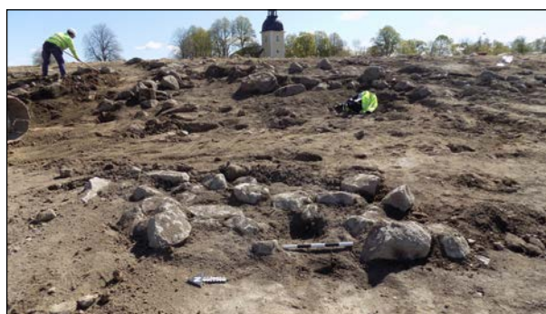
Figur 73. Schaktning pågår i västra slänten. I förgrunden syns det förmodade fundamentet A12909. Foto från väster.
