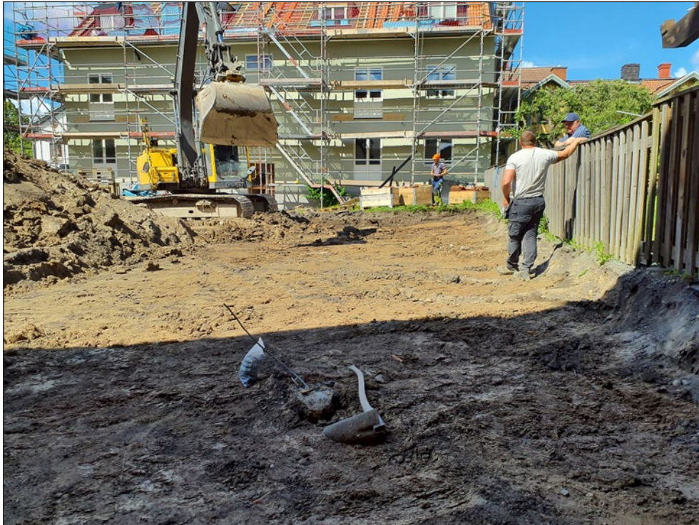
Figur 8. Vy över området i samband med schaktning av odlingslager A1. Foto från öster.
