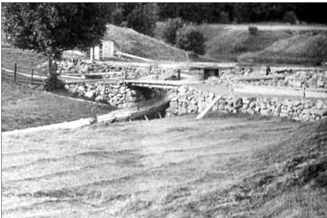
Figur 21. Detalj ur foto över Skåle gård från år 1908 (Arne Holmer R16). I fotot syns den kallmurade bron och dammvallen. Under bron syns en träränna som nyttjats vid flottning.
