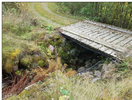
Figur 19. Omedelbart nedströms dammvallen finns en bro med kallmurade brofästen. Bron är ännu i bruk. Foto från nordöst.
