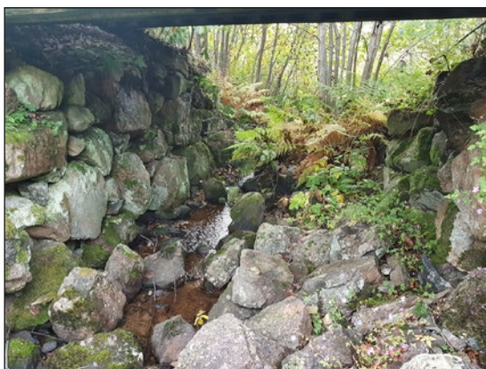
Figur 18. Dammvallen (objekt 3) sedd från bron. Dammöppningens sidor är kallmurade medan öppningen består av betong. Foto från sydväst.
