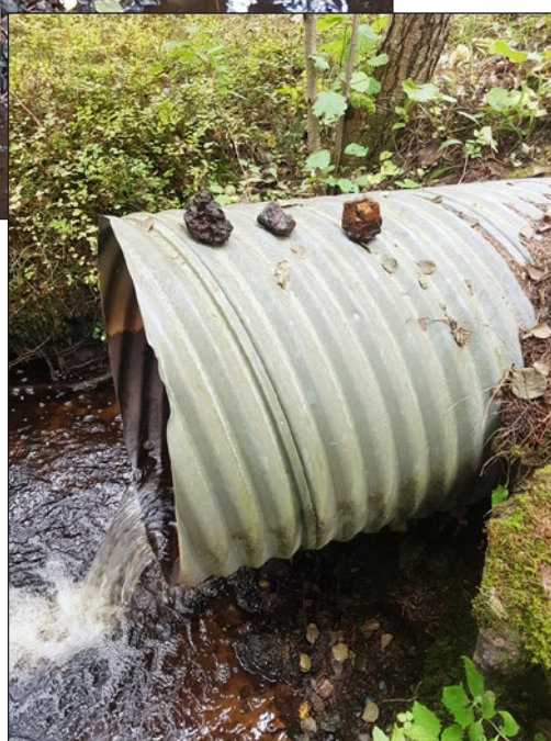
Figur 15. Då brotrumman och vägbanken synades närmare påträffades rikligt med slaggsten. I fotot syns tre upplagda slaggstenar som grävts fram ur vägbanken under brotrumman Foto från sydväst.
