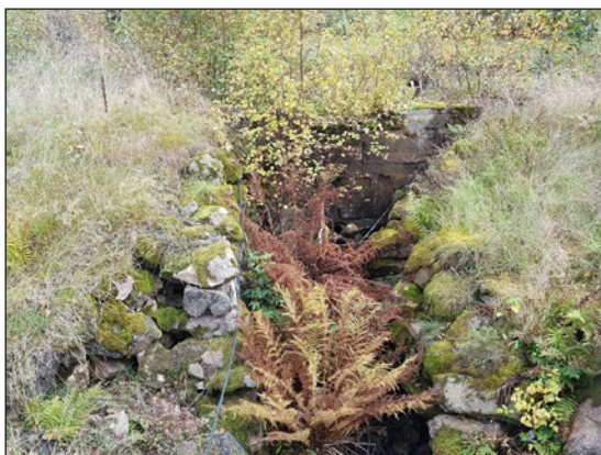
Figur 18. Dammvallen (objekt 3) sedd från bron. Dammöppningens sidor är kallmurade medan öppningen består av betong. Foto från sydväst.
