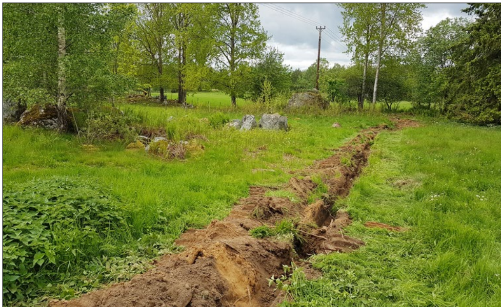
Figur 10. Vy över schakt 5 inom Simonstorps bytomt. Foto från nordväst.
