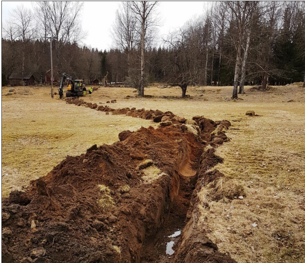
Figur 6. Vy över schakt 3 vid Skvallerbäcken väster om bäcken. Foto från öster.
