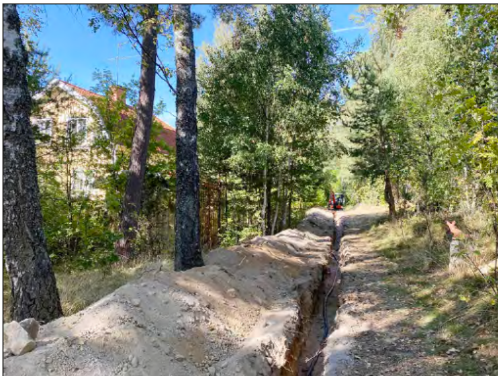
Figur 5. Nedläggning av kabel och igenläggning pågår. Foto från sydost.
