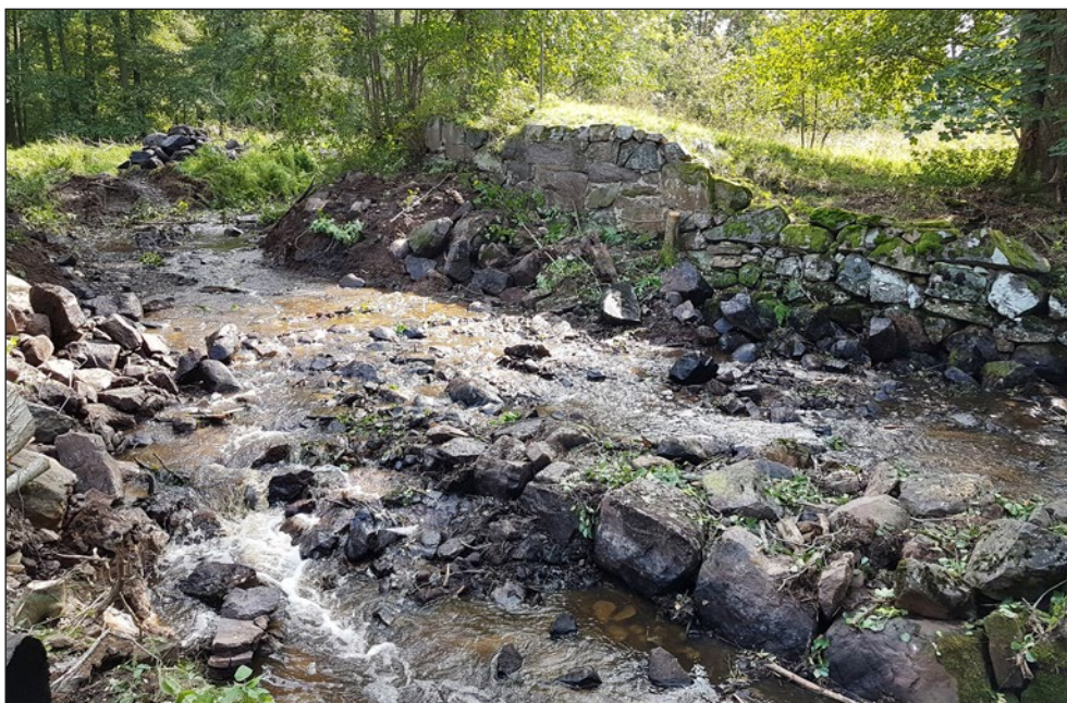
Figur 20. Vy över Nerhammarens dammöppning efter utförd åtgärd. Foto från nordväst.
