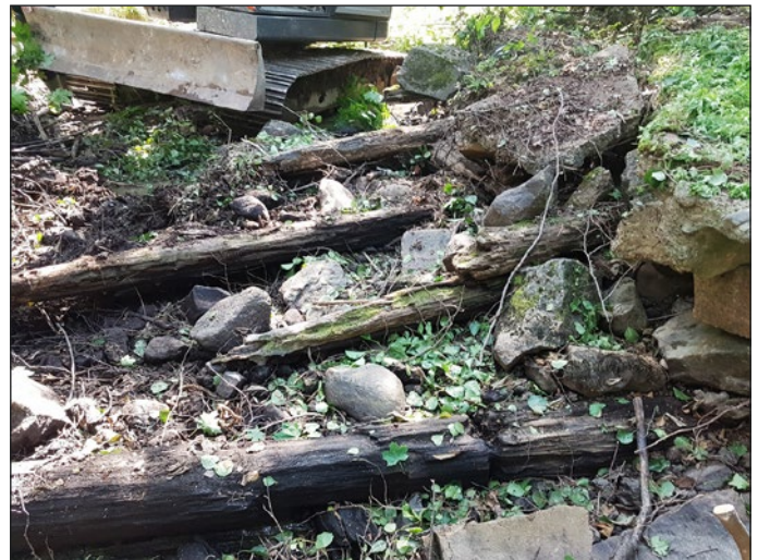
Figur 14 (till vänster). Tråkistan utgjordes av kvadratiska fack, fyllda med kolstybb, lera, morängrus och stenfyllning. Foto från nordväst. Figur 15 (ovan). Del av tråkistan (A174) som var synlig i dammöppningen inför grävning. Foto från nordväst.
