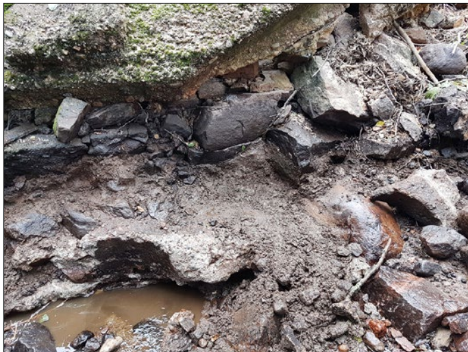
Figur 18 (ovan). Turbintrumman hade varit fastgjuten i en betongform som här påträffades emot trätoffelfabriken's terrasserade strandmur. Jämför med figur 19. Foto från sydväst.
