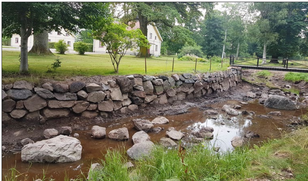
Figur 6. Vy över strandmur med huggna oregelbundna stenar. Foto från nordväst.
