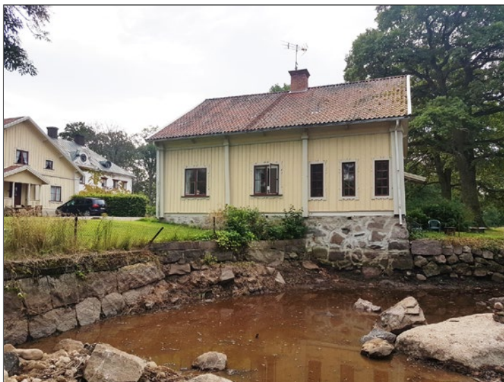
Figur 7. Vy över strandmur med kvaderhuggen sten till vänster i bild. Foto från nordväst.
