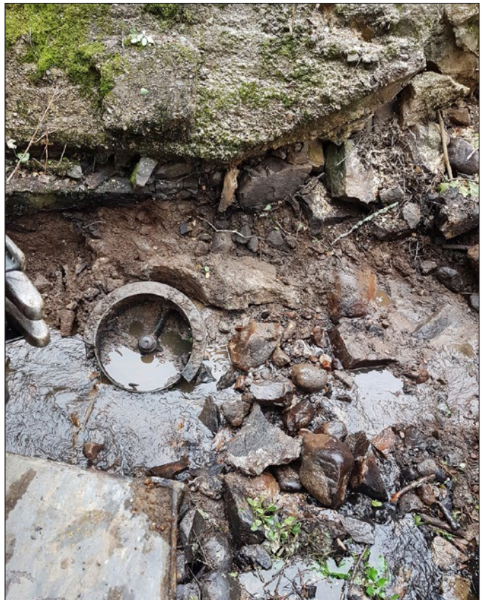
Figur 18 (ovan). Turbintrumman hade varit fastgjuten i en betongform som här påträffades emot trätoffelfabriken's terrasserade strandmur. Jämför med figur 19. Foto från sydväst.
