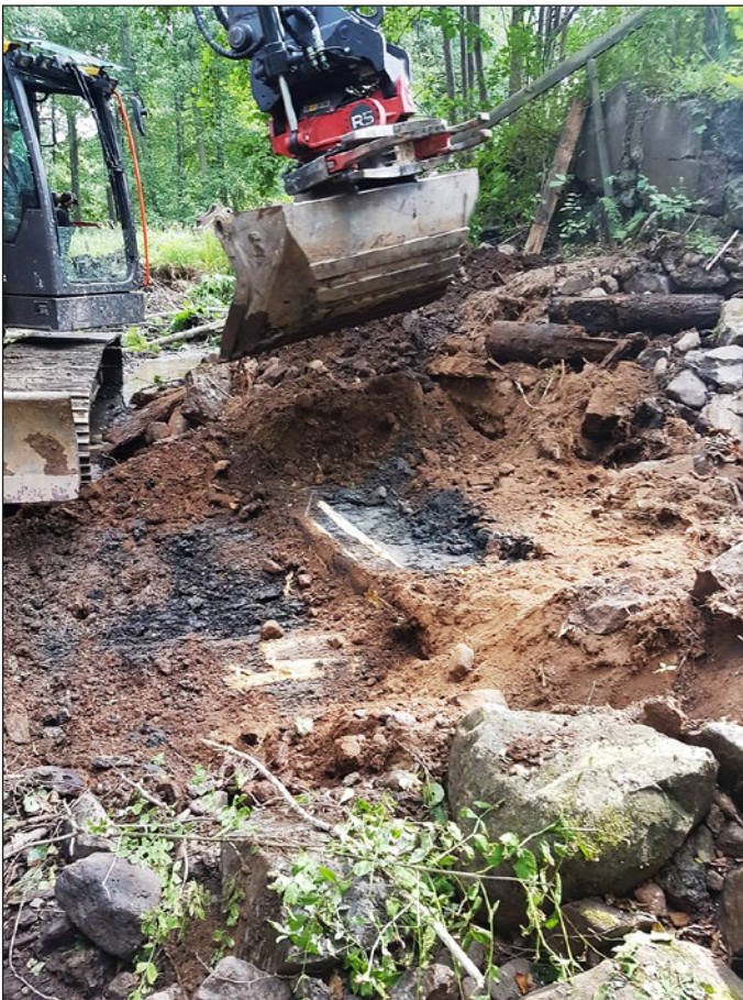
Figur 14 (till vänster). Tråkistan utgjordes av kvadratiska fack, fyllda med kolstybb, lera, morängrus och stenfyllning. Foto från nordväst. Figur 15 (ovan). Del av tråkistan (A174) som var synlig i dammöppningen inför grävning. Foto från nordväst.
