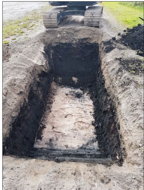
Figur 11. Tjocka svarta lager av kolstybb, här i samband med schaktning vid schakt 5. Foto från norr.
