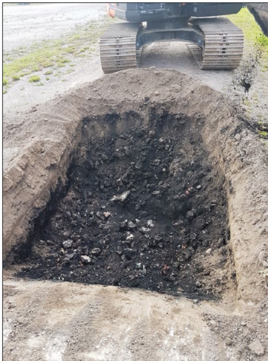
Figur 10. Utfyllnadslager av slagg (A4), här i schakt 2. Foto från norr.
