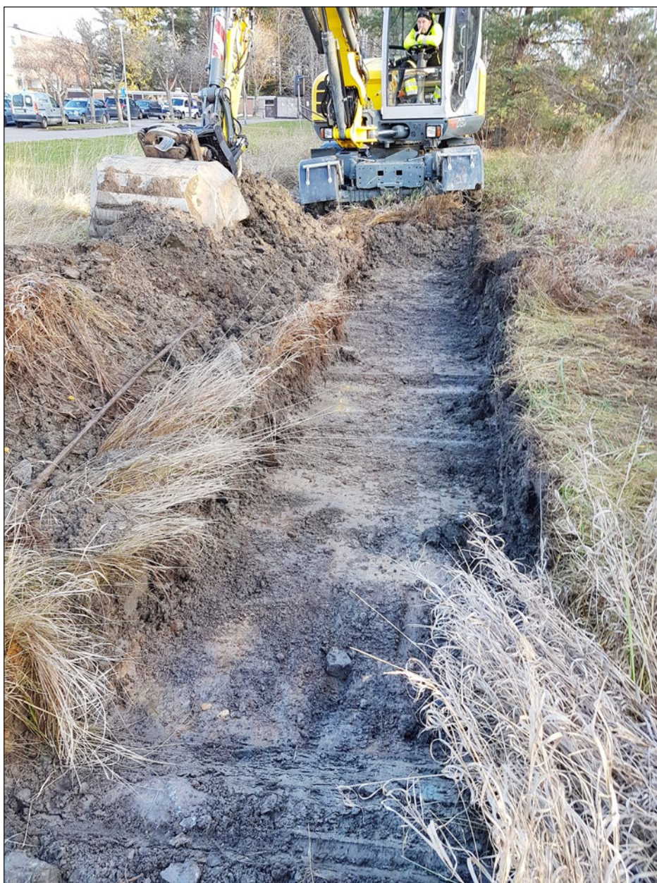
Figur 12. Schakt 146 med sank botten. Sett från väster.
