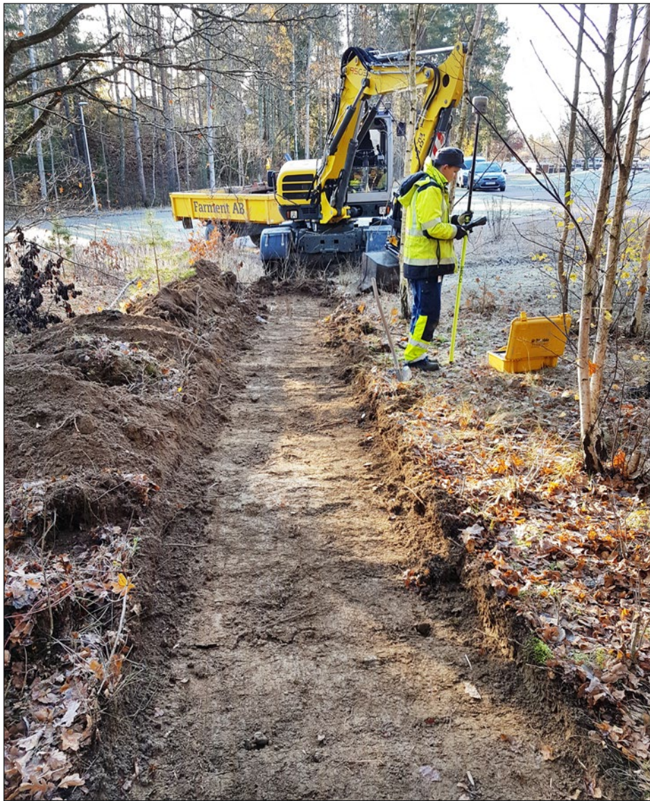
Figur 8. Johnny Rönngren i färd med att mäta in schakt S100, sett från norr.
