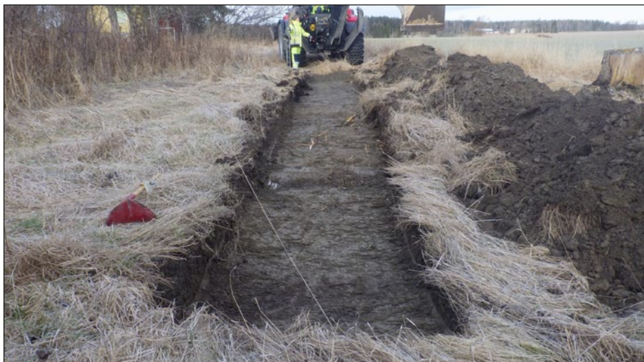
Figur 5. Schakt S104 sett från öster.
