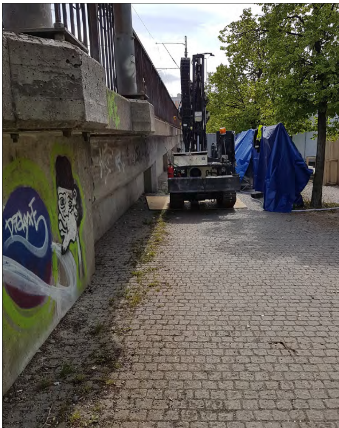
Figur 3. Boring pågår. Foto från norr.
