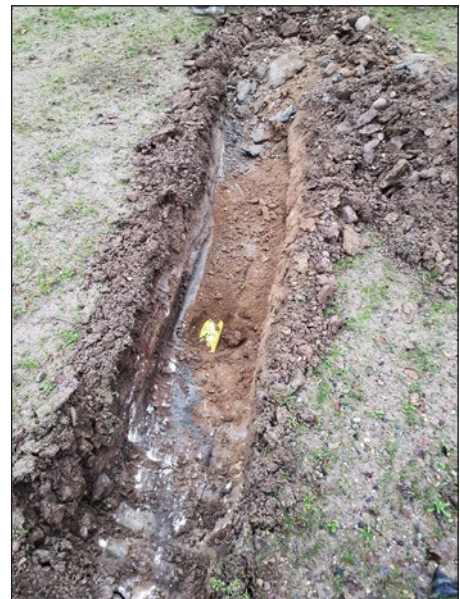
Figur 5. Gul kabelledning i botten av schakt 201. Foto från nordöst.
