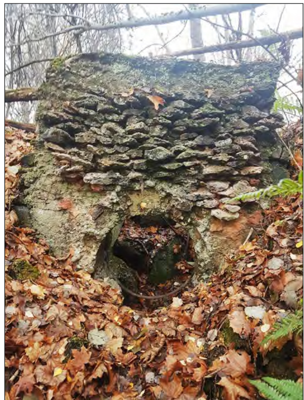
Figur 46. Turbinrummet inom objekt 21, sedd från sydöst. I nedre delen av byggnadens syns utloppstrumman varifrån en trumma ledde vattnet vidare ned mot Torphyttabäcken.
