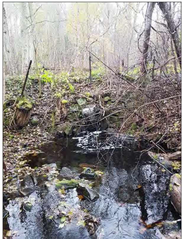
Figur 23. Broövergången vid Munkhyttans hyttbacke (objekt 6) består av en sten- och jordfylld vägbank med betongtrumma med en betongdamm uppström. Sannolikt har här ursprungligen funnits en brodamm. Foto från öster.
