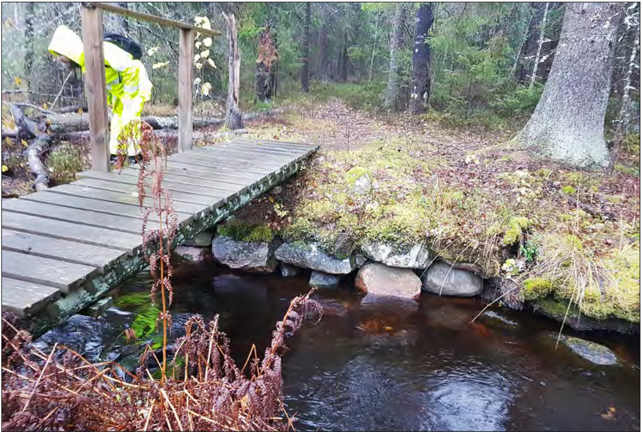
Figur 25. Vy över brons (objekt 9) östra landfäste av kallmurade stenar. Tobias Vinoy betraktar det västra landfästets utrasade stenar.
