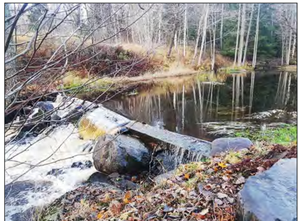
Figur 39. Dammvallen bestående av stenar av olika slag har nyligen ombyggts. Foto från sydöst.
