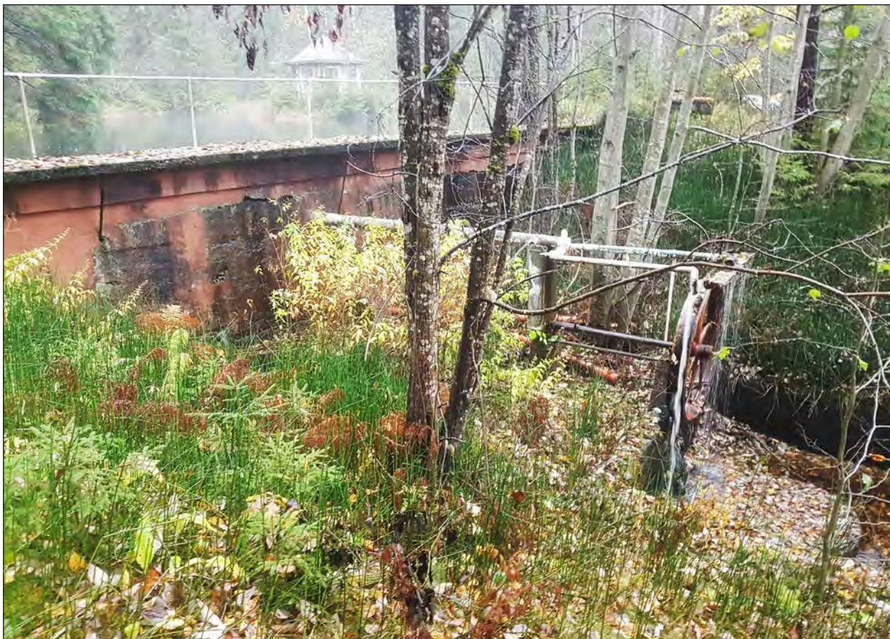
Figur 26. Kvarndammens (objekt 10) södra del med läge för kvarngrunden. Foto från sydöst.
