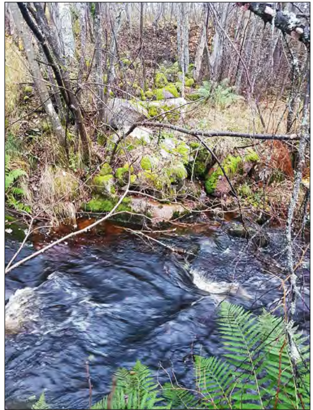
Figur 33. Den östra dammvallen i Lindeshytten (objekt 16), sedd från väster. Den kallmurade dammvallen sträcker sig ända fram till vattendraget.
