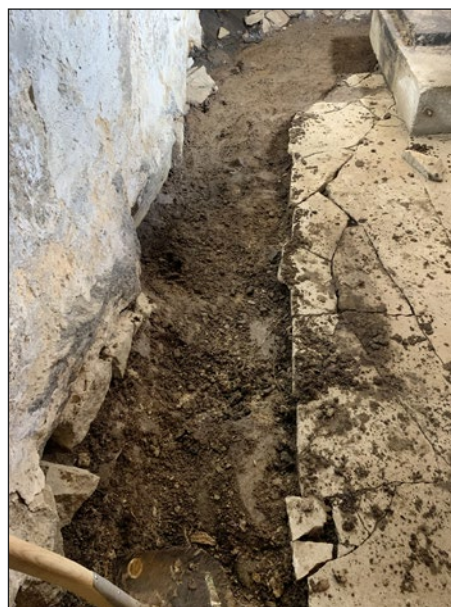
Figur 8. Det grävda schaktet inne i kvarnbyggnaden. Foto från öster.
