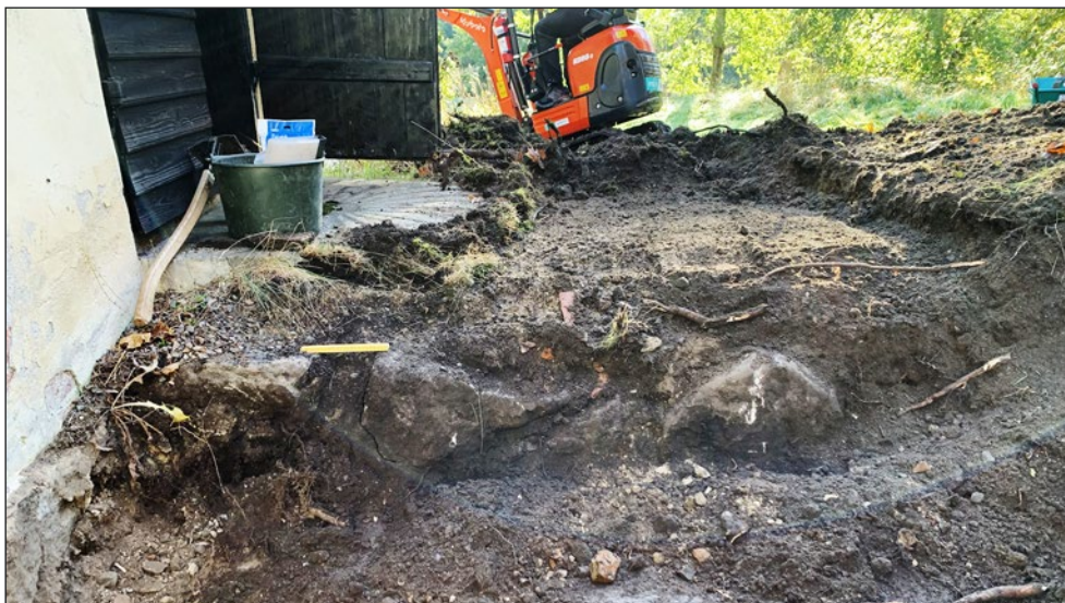
Figur 6. Ramp med förstärkning (A2) sedd från väster.
