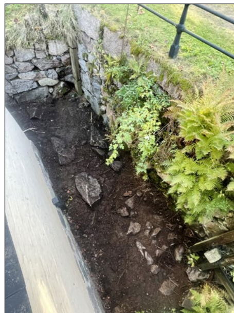
Figur 5. Stenfundamentet A1 låg invid befintligt brofäste. Snett lodfoto från nord-nordöst.
